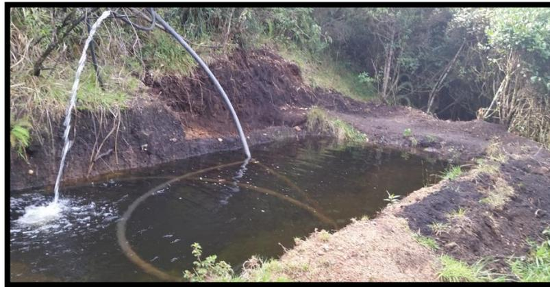
*Figura 50:* Profundidad del pozo y sistema anti impurezas para el inyector.
