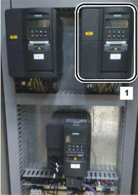
Figura 1. Ubicación del variador de frecuencia Micromaster 440.
