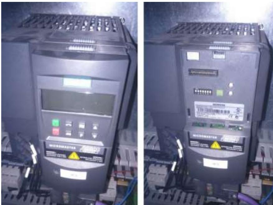
**Figura 3. 2** Micro-master 440 con la pantalla (izq.) y sin la pantalla (der.) [fuente: los autores].
