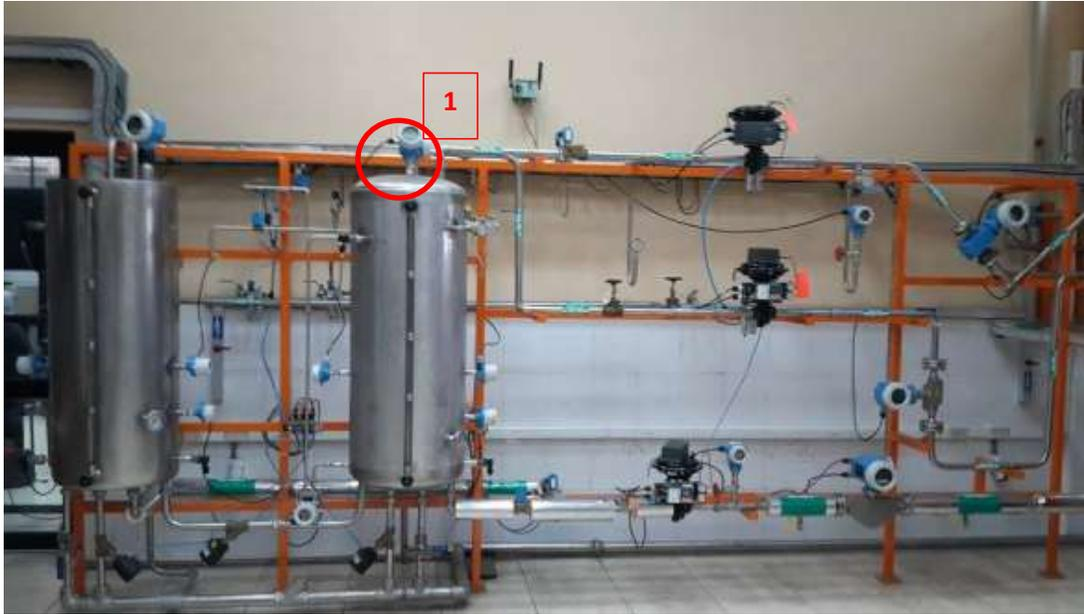
Figura 1. Ubicación del transductor Deltabar Levelflex FMP51.
