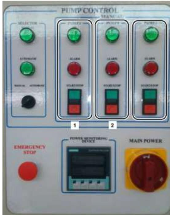
Figura 6. Pulsantes de arranque para los variadores de frecuencia (1, arranque del variador HART; 2 arranque del variador Foundation Fieldbus).
