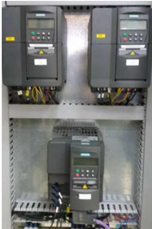
**Figura 1.21** Variadores de frecuencia presentes en la Planta de control de procesos “A”
