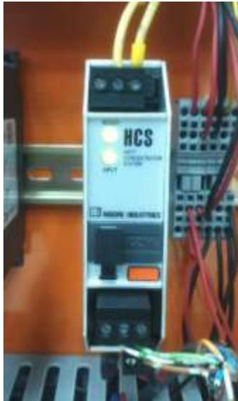
Figura 1. Ubicación del HCS en el armario de la planta de control de procesos “A”.
