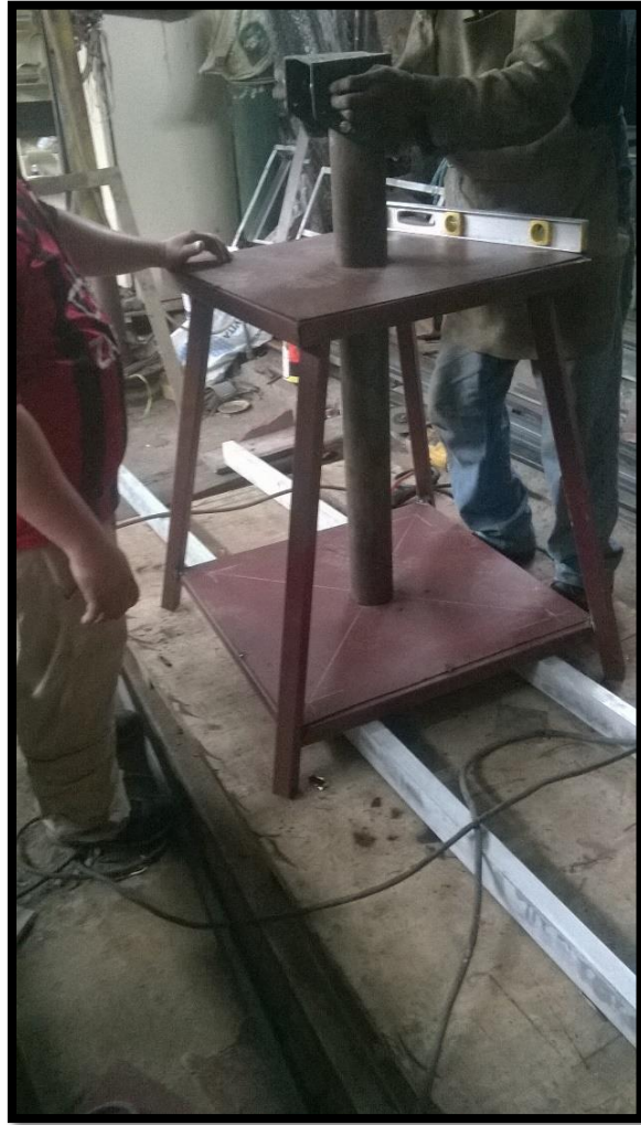
Figura 26. Construcción de la base.
