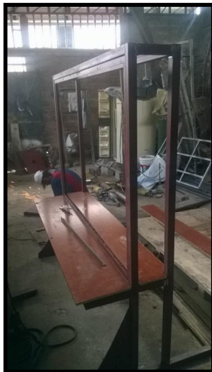
Figura 19. Mesa y estructura
