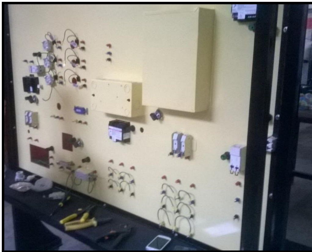
Figura 32. Cableado de equipos.
