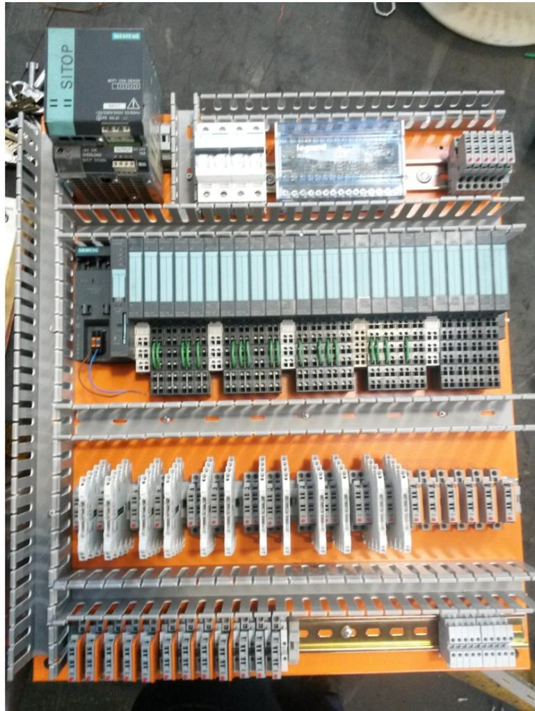
**Figura 3.3:** Distribución de elementos de control dentro del tablero
