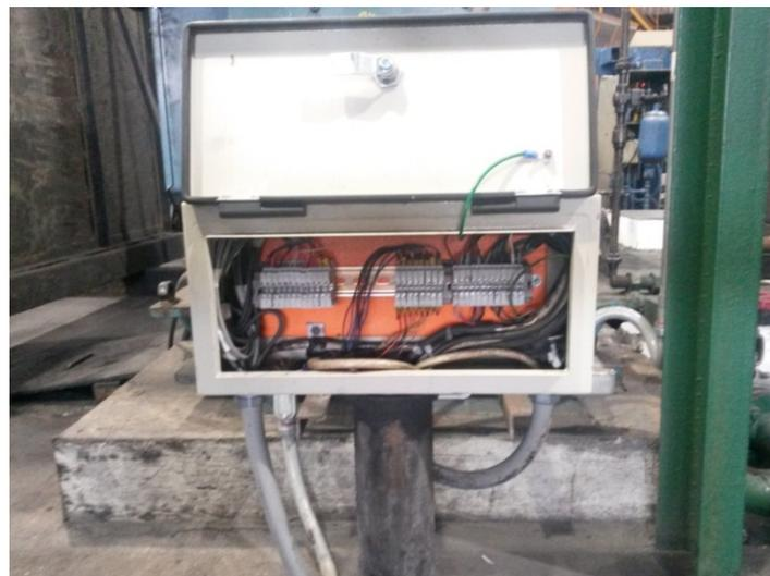
**Figura 3.9:** Vista interna de la caja de paso
