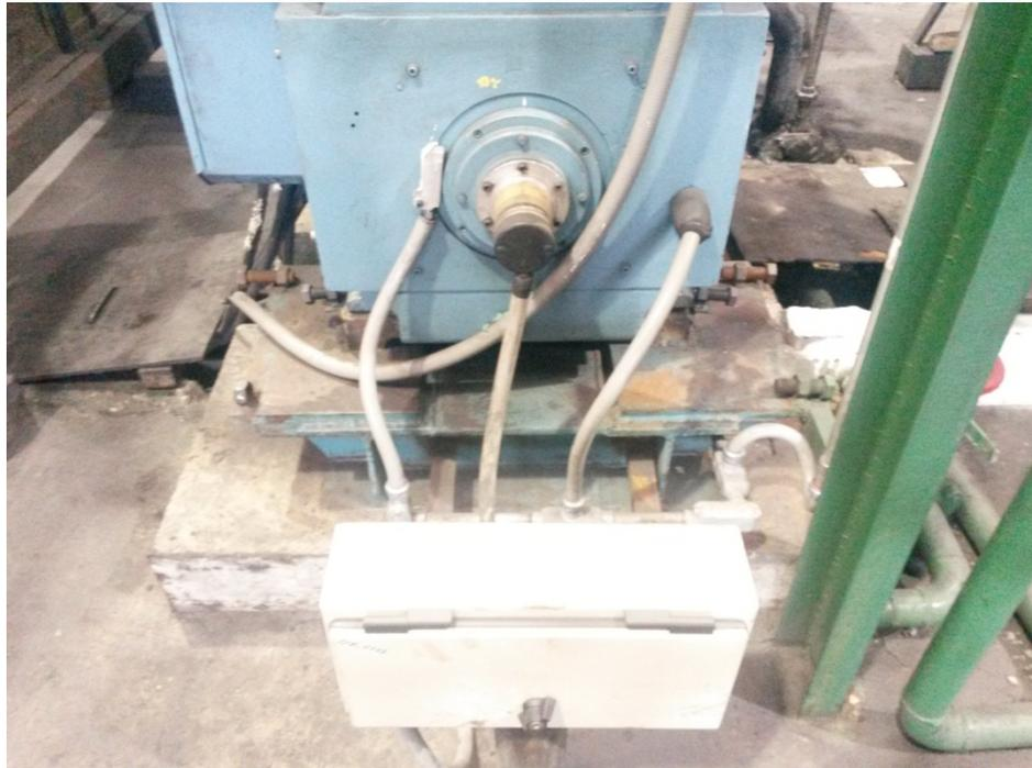
**Figura 3.17:** Vista de los sensores de temperatura vibración y caja de paso.
