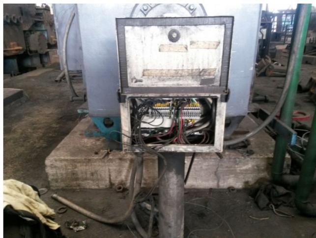
**Figura 3.7:** Caja de paso a reemplazar por deterioro y falta de espacio
