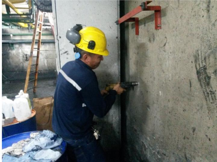
**Figura 3.10:** Perforación para la colocación de los pernos de expansión
