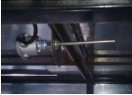
Figura N°3.25 Sensor de temperatura tipo PT-100. Foto de la ubicación del sensor en la pared superior media de la cámara interna del cubículo.
