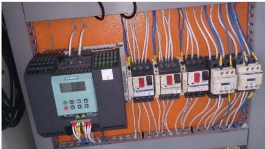
Figura N°3.19 Tablero de control. Foto del variador de frecuencia, 3 guardamotores y 2 contactores.
