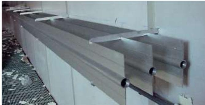
Figura N°2.8 Tuberías radiantes de aletas por agua caliente. Ejemplo de un sistema tuberías radiantes con circulación de agua caliente. IDAE (2005). Recuperado de [http://www.idae.es/uploads/documentos/documentos\\_10330\\_Instalaciones\\_ganaderas\\_05\\_8ad73059.pdf](http://www.idae.es/uploads/documentos/documentos_10330_Instalaciones_ganaderas_05_8ad73059.pdf)
