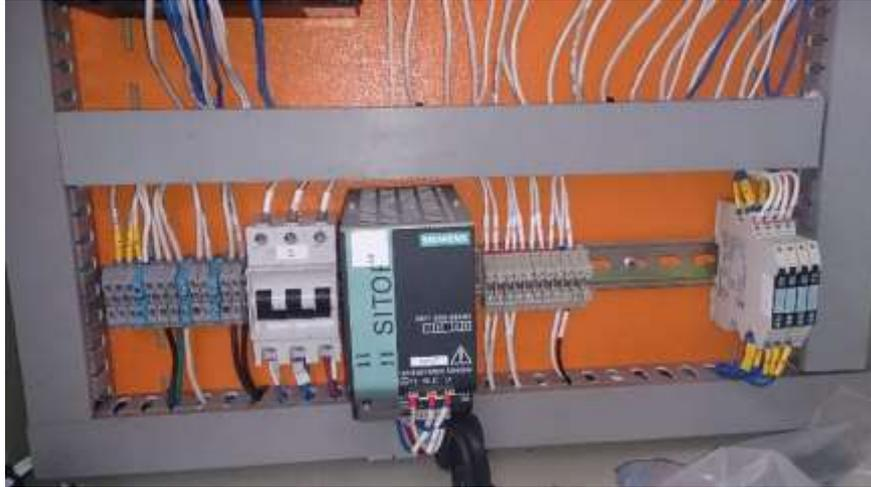
Figura N°3.20 Tablero de control. Foto de borneras, breaker, fuente de poder, bornera y relés.
