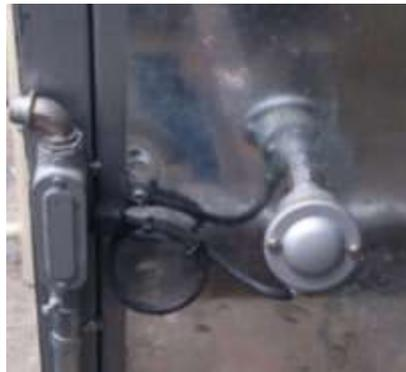
Figura N°3.27 Sensor de temperatura tipo PT-100 parte externa. Foto de la ubicación del sensor en la pared inferior izquierda de la cámara interna del cubículo.
