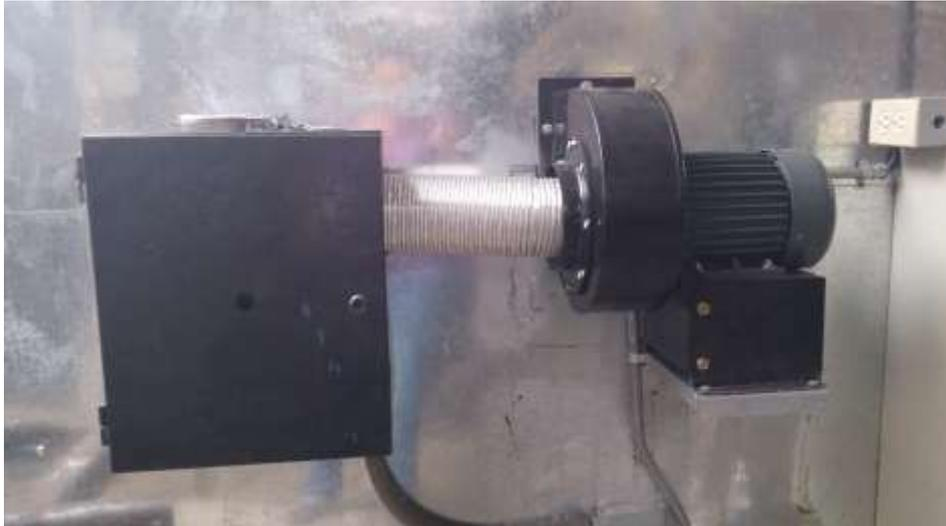
Figura N°3.16 Soplador de aire caliente y ductería hacia el cubículo. Foto real del soplador de aire (blower) y ductería de aire utilizada en el sistema de climatización.
