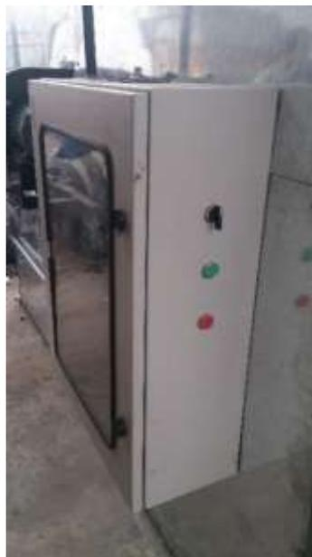
Figura N°3.21 Tablero de control vista lateral. Foto de pulsante de marcha, paro y selector de modo.
