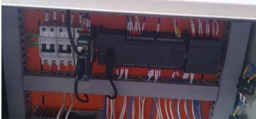
Figura N°3.18 Tablero de control. Foto del breaker, Sinuat, PLC y tarjetas de entradas y salidas.
