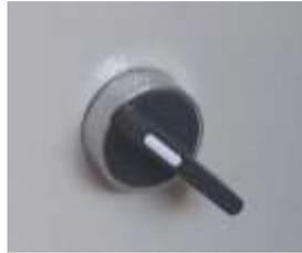
Figura N°3.22 Tablero de control. Foto de selector negro manual | 0 | automático
