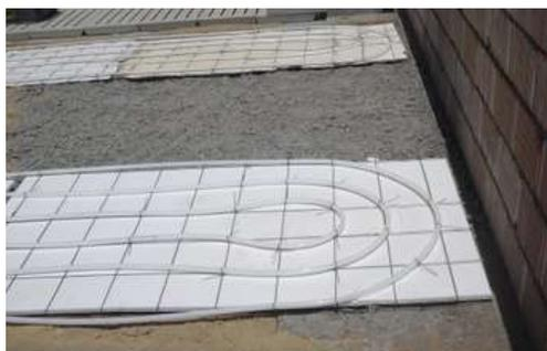
Figura N°2.9 Colocación de suelo radiante en una granja porcina en construcción. Ejemplo de una instalación de suelo radiante en una granja porcina. Blanco R., García F. (2013). Recuperado de <http://www.chil.org/blogpost/calefaccion-de-instalaciones-de-porcino-con-suelo-radiante-de-agua-caliente/2357>
