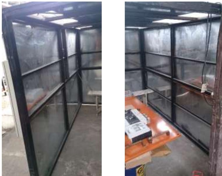
Figura N°3.10 Ensamblado de la pared lateral izquierda y derecha del cubículo. Foto real de la parte interna del cubículo.
