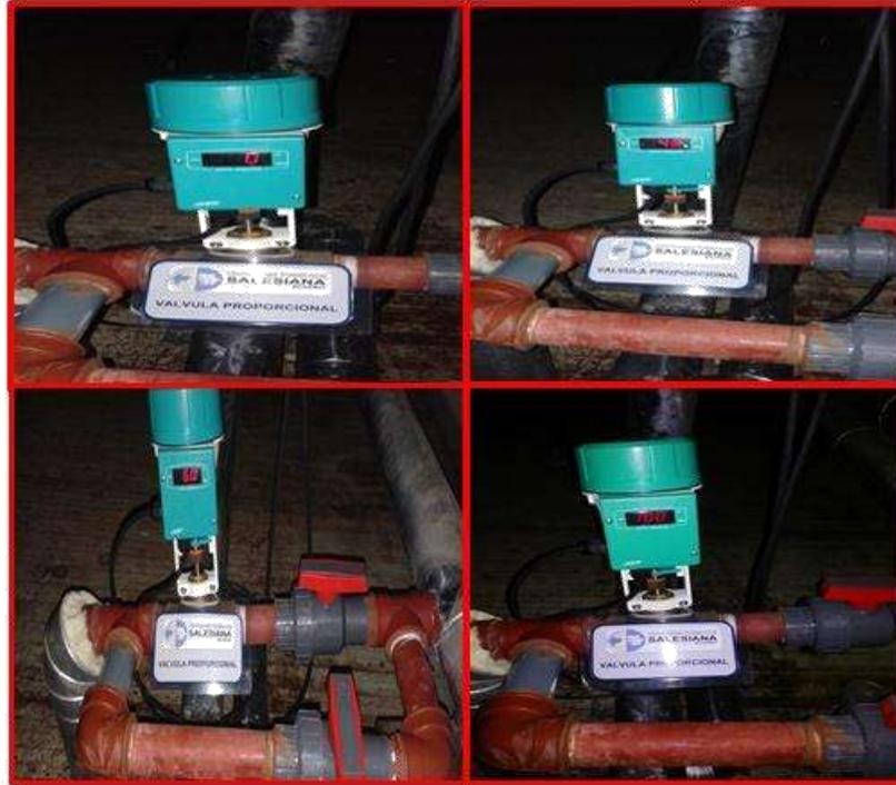
**Figura 3.57: Funcionamiento de Válvulas.** Secuencia de apertura de la válvula proporcional.
