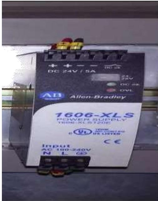
**Figura 3.51: Fuente de alimentación 24VDC.** Fuente Allen Bradley 1606 XLS
