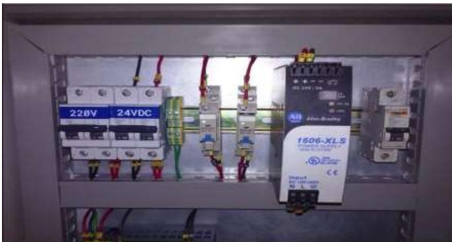
**Figura 3.50: Elementos de protección.** Breakers Schneider y Fuente de alimentación de 24 VDC Allen Bradley.
