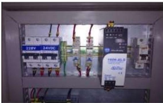
**Figura 3.14: Montaje de elementos de protección y fuente de alimentación.** Alimentación de 220VAC y fuente de alimentación 24 VDC.
