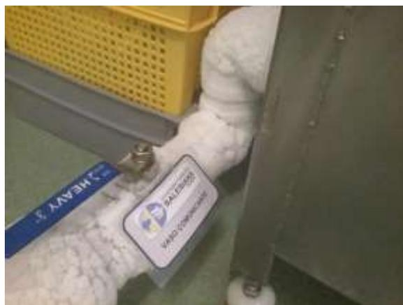
**Figura 3.56: Vaso comunicante. Tubería de 2” para unir los bucos de la línea de congelación 1.**
