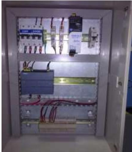
**Figura 3.53: Montaje del PLC.** Montaje conexión del PLC con borneras.
