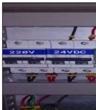
**Figura 3.52: Protección del control 24VDC.** Breakers 2P 2A Schneider.
