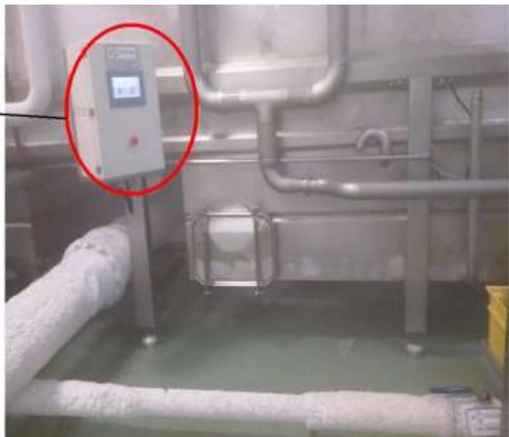
**Figura 3.58: Ubicación del tablero de control.** Tablero de control del sistema de llenado de los bucos en la línea de congelación 1.
