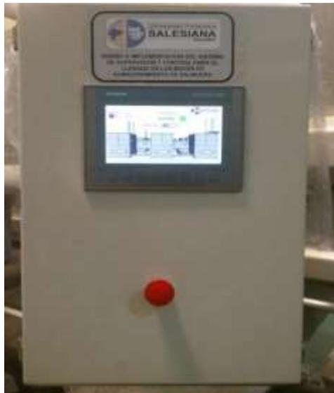
**Figura 3.59: Vista frontal del touch panel.** Touch panel montado en el tablero de control del sistema.
