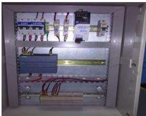
**Figura 3.15: Cableado del tablero control.** Conexión de los equipos de control y salidas a borneras.
