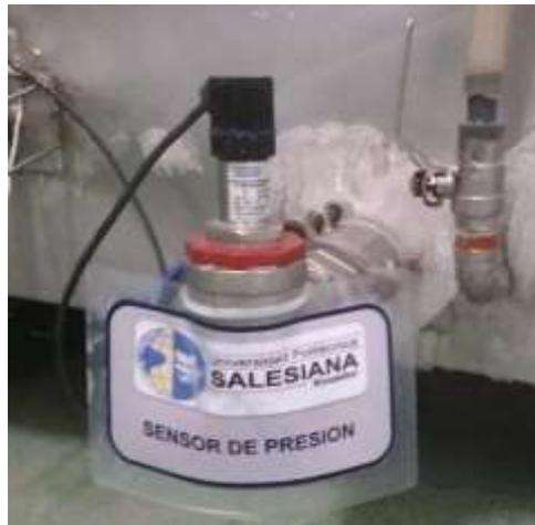
**Figura 3.55: Sensor de Transmisor de presión. WIKA 0 – 0,3 BAR**
