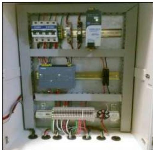
**Figura 3.54: Tablero de control energizado.** PLC y fuente de 24 VDC energizadas.
