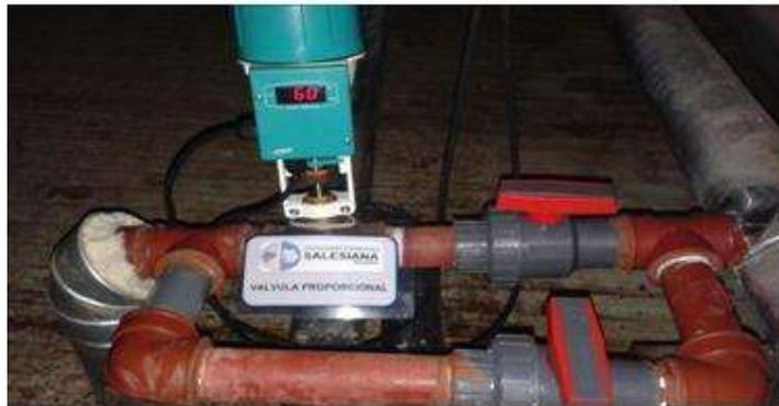
**Figura 3.44: Montaje de válvula proporcional.** Conexión de la válvula proporcional al sistema de tuberías de la red de salmuera.
