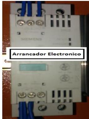
**Figura 50:** Arrancador Electrónico.
