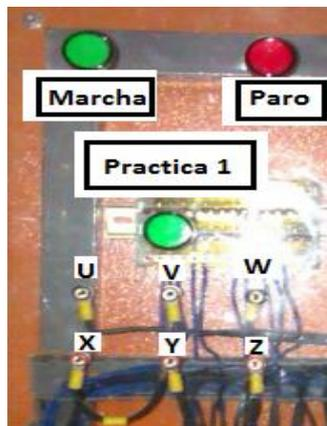
**Figura 47:** Conexión del motor Trifásico.
