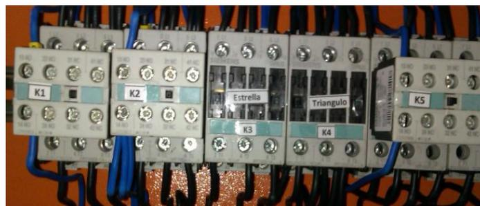
**Figura 38:** Conexión de Contactores. Utilizados para activación de motor trifásico.
