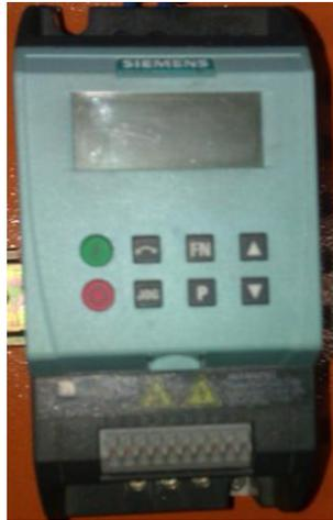
**Figura 19:** Variador Sinamics G110. Variador de frecuencia de 0 a 60 hz.
