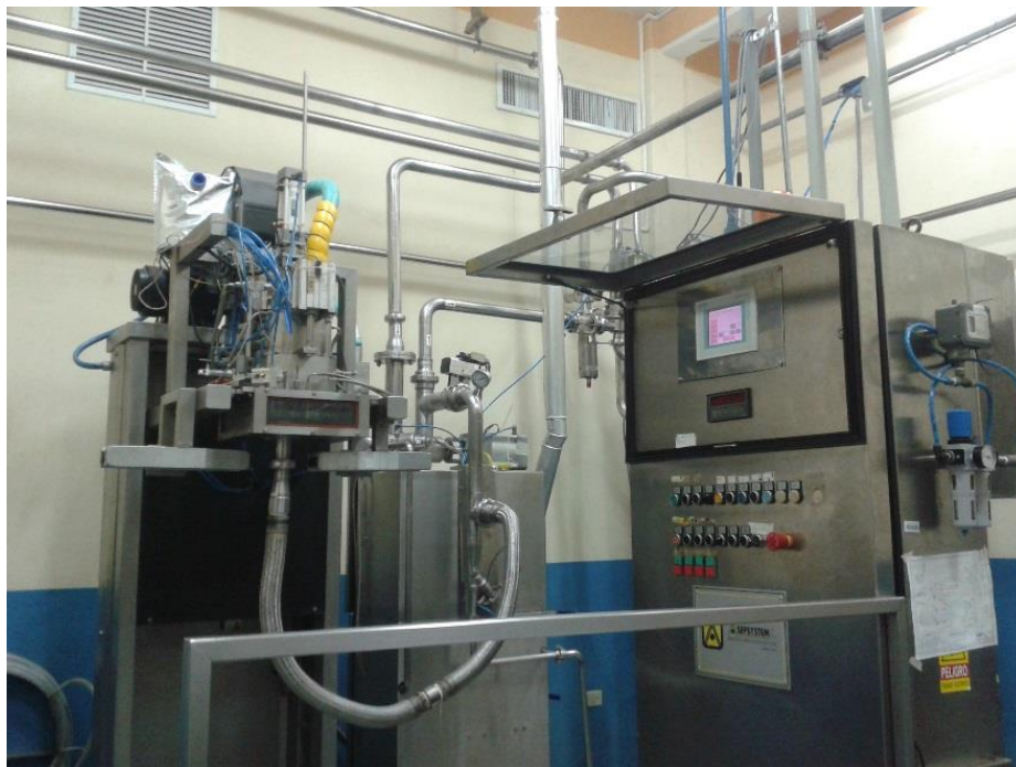
Figura 74: Llenadora Aséptica. Se puede visualizar parte del sistema de llenado aséptico, el cabezal para realizar el llenado y el tablero del operador desde donde se controla los procesos que se realizan. Ubicado en la AGRO INDUSTRIAL FRUTAS DE LA PASIÓN C. LTDA.
