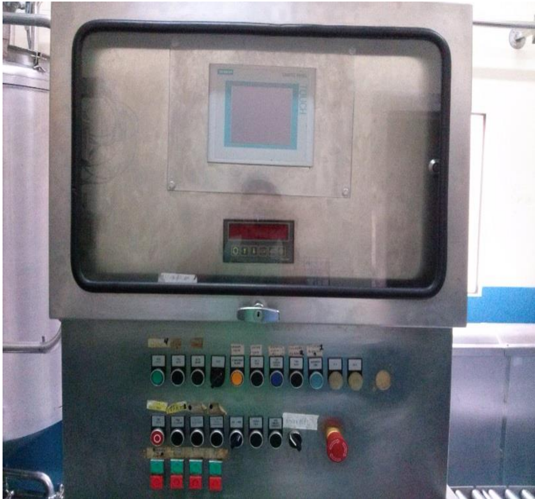
Figura 6: Panel de operador. Permite al operario interactuar, interferir en el proceso que se esté desarrollando.
