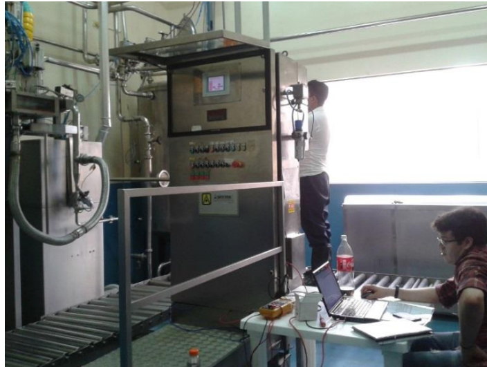
Figura 77: Prueba Funcionamiento 1. Se muestra las pruebas que se están realizando antes de poner en marcha el proceso. Ubicado en la AGRO INDUSTRIAL FRUTAS DE LA PASIÓN C. LTDA.
