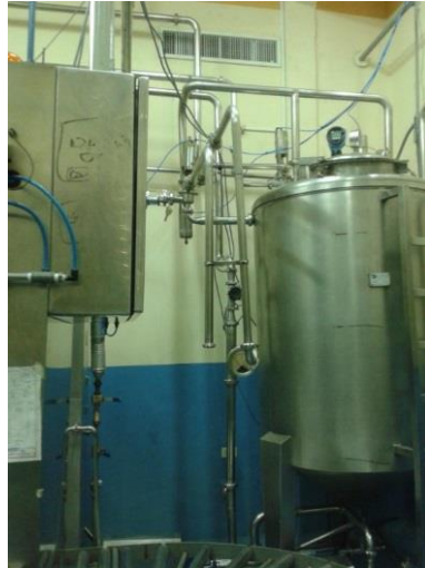
Figura 75: Tanque Pulmón. Se puede visualizar parte del sistema de llenado aséptico, el tanque pulmón donde es llenado con el producto al iniciar el proceso de producción. Ubicado en la AGRO INDUSTRIAL FRUTAS DE LA PASIÓN C. LTDA.
