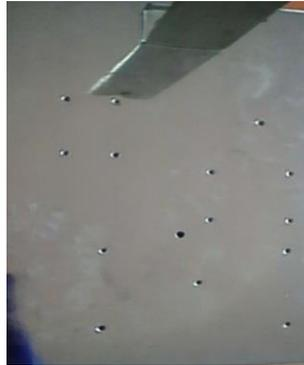
**Figura 3.17 Perforaciones en base de la plataforma.** Vista superior de la base de la planta.
