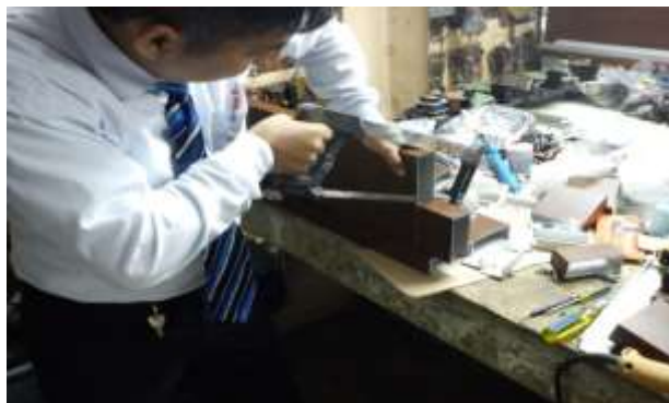
Foto 3.1. Corte de tubo rectangular de aluminio. Preparación del marco de la estructura. Fuente: (Autores)
