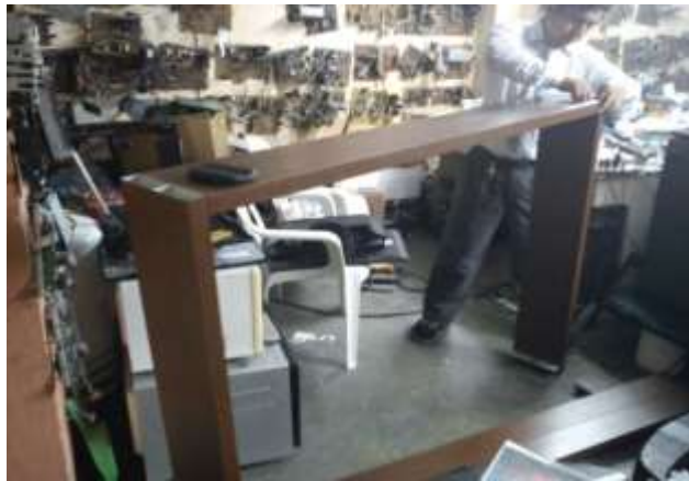
Foto 3.3. Ensamblaje de la estructura de aluminio. Perforación de la estructura para colocación de pernos. Fuente: (Autores)
