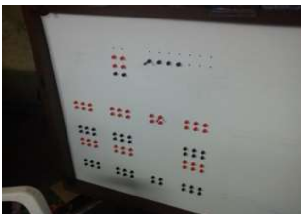
Foto 3.7. Perforación e instalación de borneras. Distribución de las borneras en el panel frontal. Fuente: (Autores)
