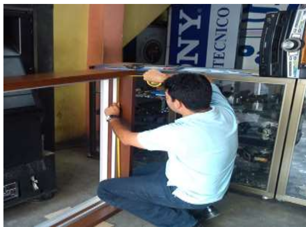
Foto 3.4. Instalación de los soportes interiores. Perforación de la estructura para colocación de marco del panel frontal y posterior. Fuente: (Autores)
