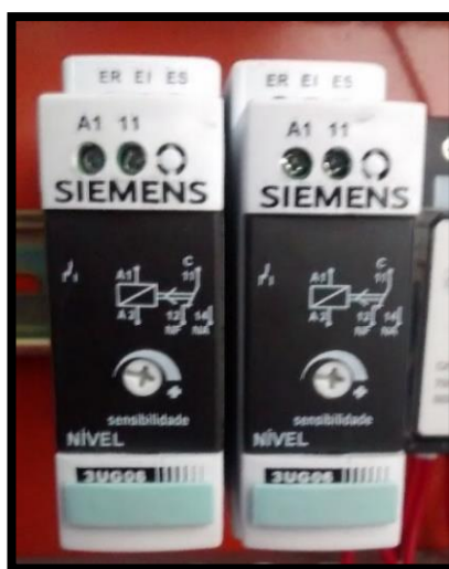
Figura 2.17: Relé de nivel. Dispositivos de medición de nivel con electrodos tipos resistivo o conductivo. Siemens, (2015)
