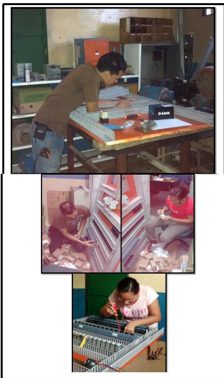
Figura 4.7 Montaje eléctrico del tablero. Colocación de elementos y cableado de los mismos.
