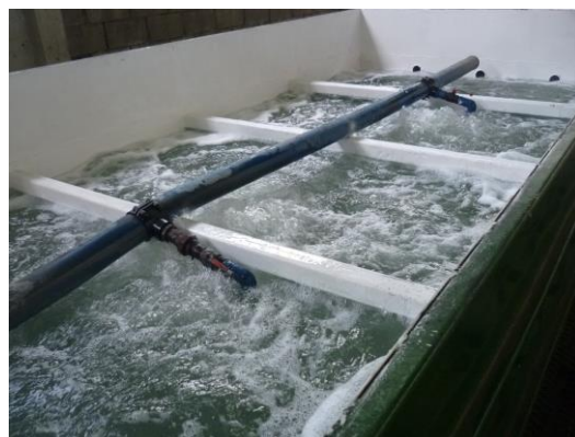
Fotografía 2.- Reactor biológico de aireación extendida (después) en operación
