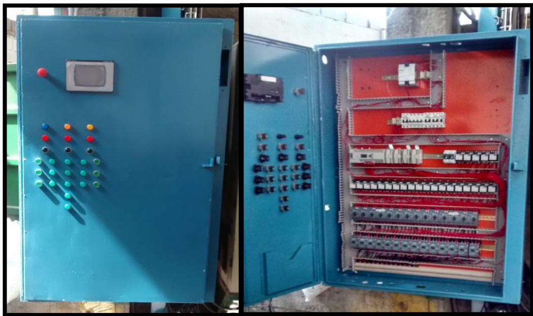
Figura 4.10 Montaje Final del tablero. Colocación de últimos elementos del tablero.
