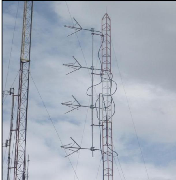
Figura 1.9: Antena Dipolo Ubicada en Cuenca
