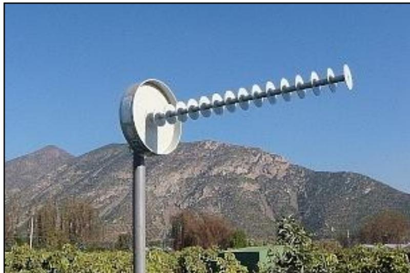
Figura 1.14: Antena helicoidal usada en televisión por cable
