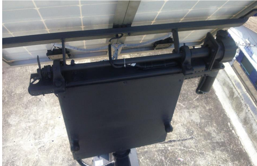
Figura 30: Vista superficial Movimiento de Elevación
