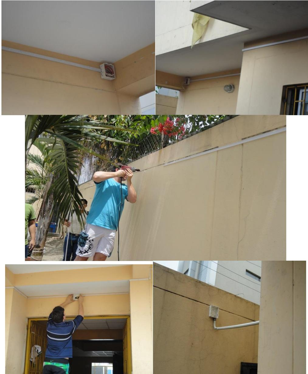
**Figura 3.30** Instalación de canaletas y tuberías. Canaletas ubicadas en el exterior tanto en la parte frontal y posterior de la fundación y tuberías por cielo raso para respectiva protección de los cables.
