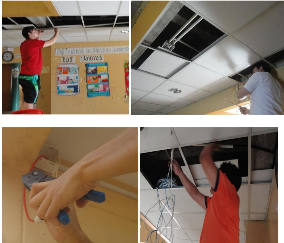
**Figura 3.31** Cableado de alimentación y comunicación a equipos. Se utilizó cable AWG#16 para alimentación de los equipos y cable UTP cat. 6 para las cámaras con conector RJ45.
