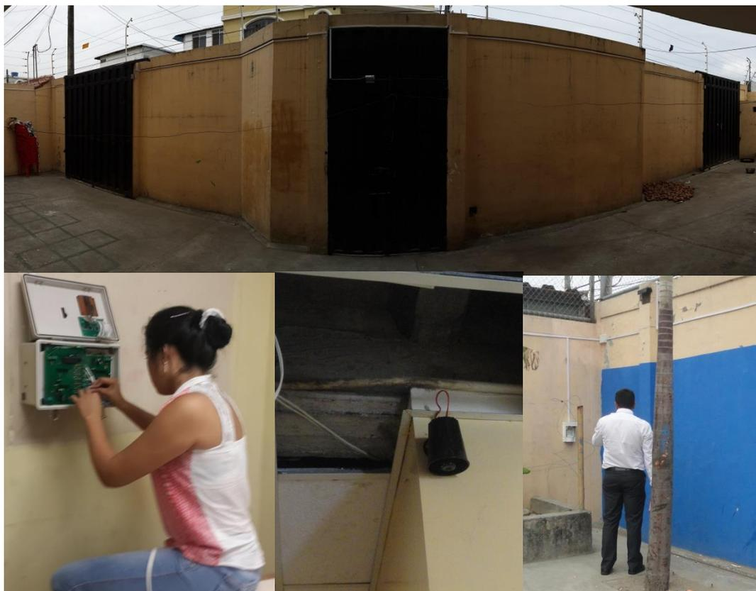
**Figura 3.33** Montaje de equipos perteneciente a la central de alarma.
