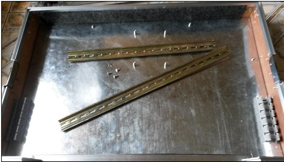
Figura 47. Montaje de Plancha Metálica.
