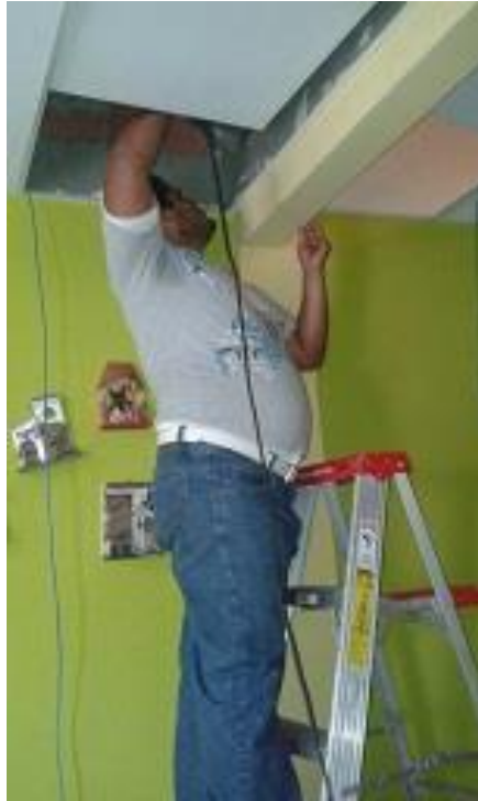
Anexo 5: Taladrado de pared para cable de cámara Fuente: Los Autores
