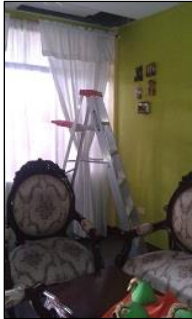
Anexo 1: Estado de la casa antes de iniciar (área 1) Fuente: Los Autores
