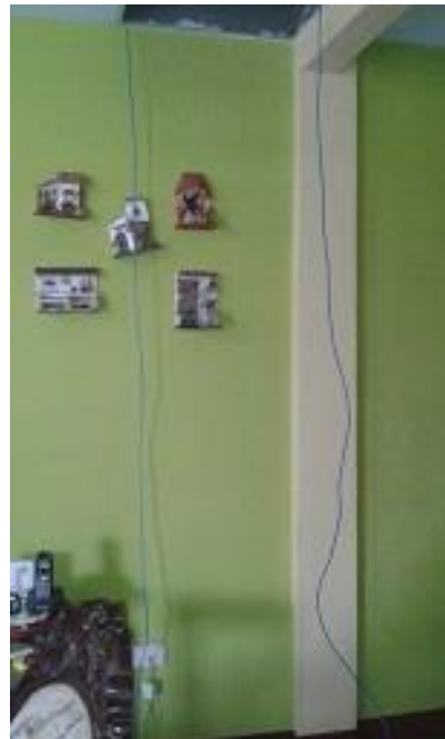
Anexo 6: Tendido de cables de para control de luces Fuente: Los Autores
