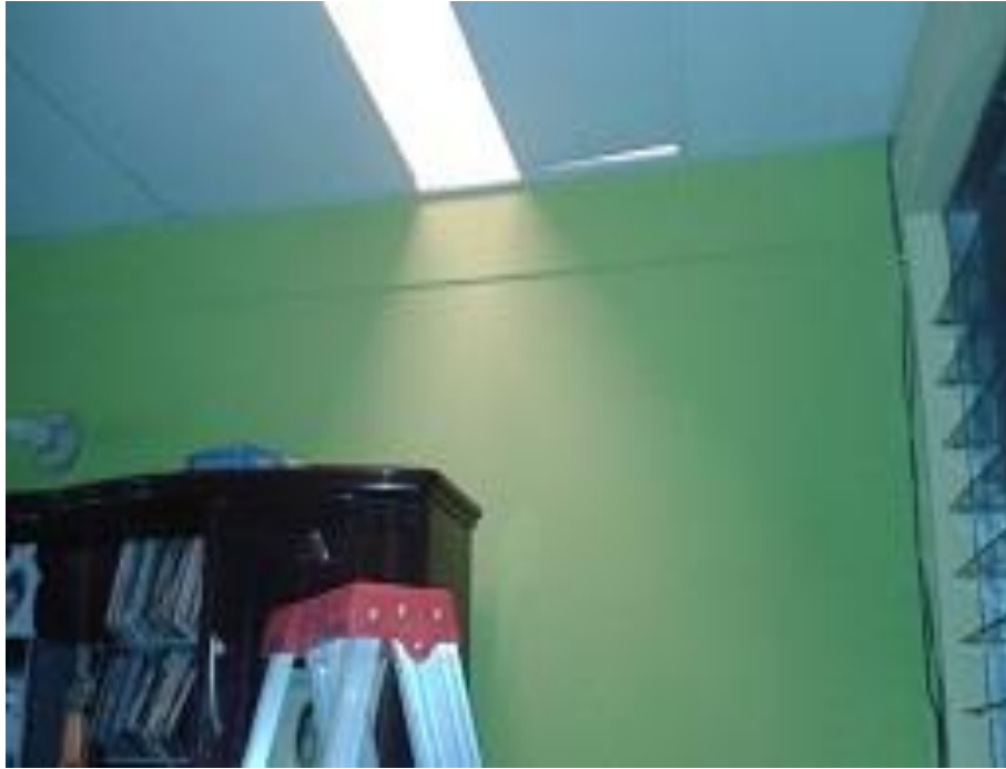
Anexo 3: Estado de la casa antes de iniciar (área 3) Fuente: Los Autores
