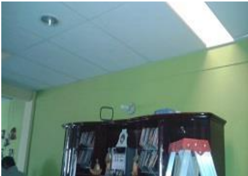
Anexo 4: Estado de la casa antes de iniciar (área 4) Fuente: Los Autores
