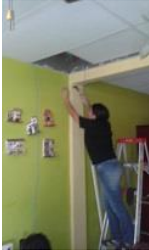
Anexo 9: Orificio superior para colocación de canaleta Fuente: Los Autores
