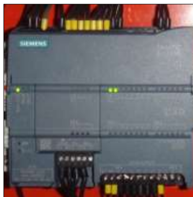
Figura 3. 11 PLC S7-1200 instalado en la consola. (SIEMENS, 2009)
