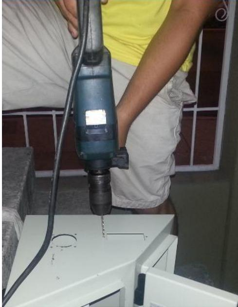
Figura 3. 6 Taladrado para el puerto de comunicación. Se realizó el taladrado para los tornillos del puerto Ethernet.
