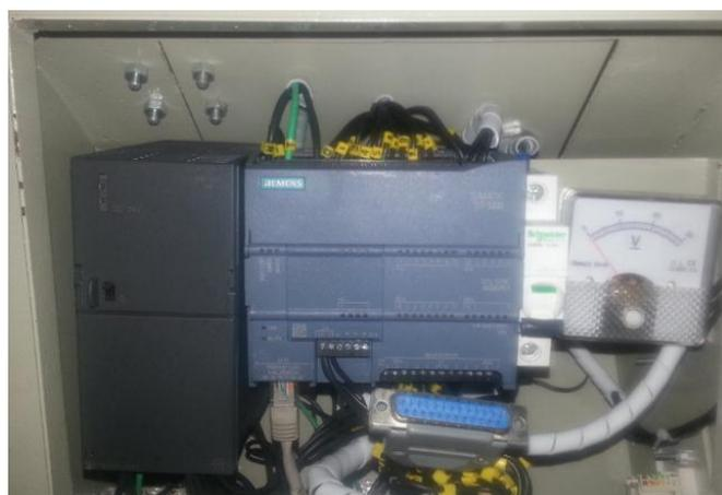
Figura 3. 17 Conexiones del PLC. Para la identificación de las direcciones se colocan marquillas enumeradas.
