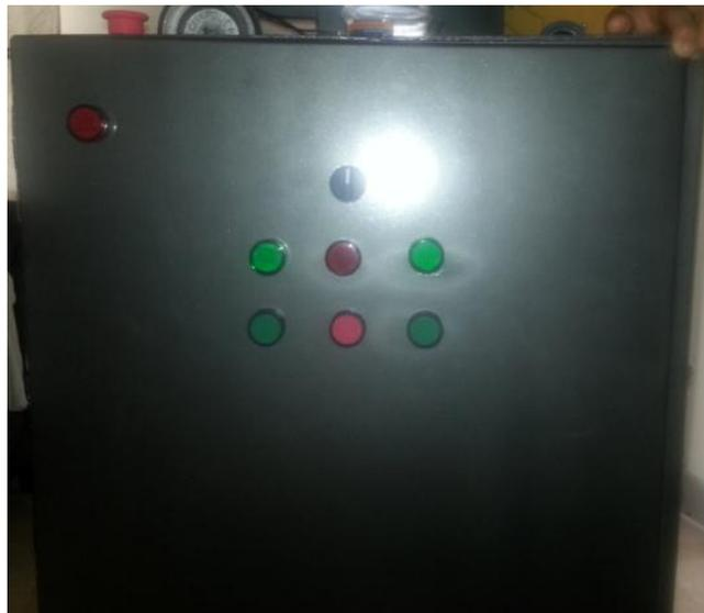
Figura 3. 23 Panel de operación. Panel de operación del módulo de dosificación, donde están los pulsantes de paro, marcha, reset.
