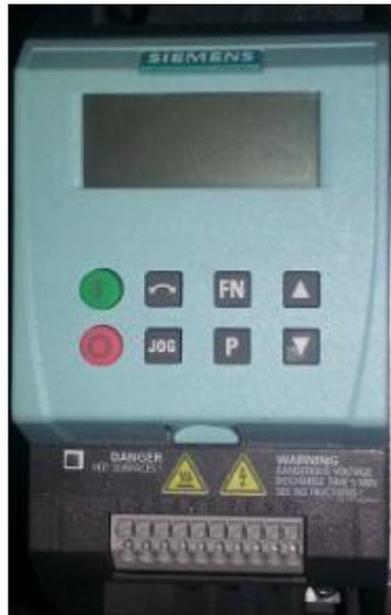
Figura 3. 35 Variador de frecuencia para dosificación. Este es un variador de frecuencia de la marca siemens.
