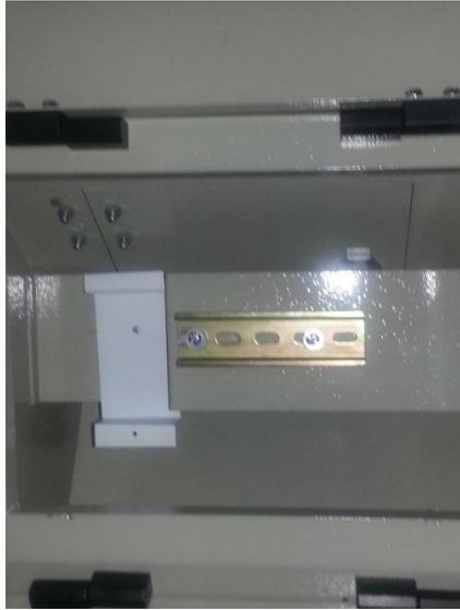
Figura 3. 10 Riel DIN para montaje horizontal. Para el riel de la fuente de 24v se lo realizo diferente a la medida estándar de riel DIN.
