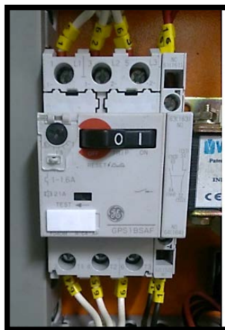
Figura 2.4: Guarda motor de 1 a 1.6 Amp modelo Surion
