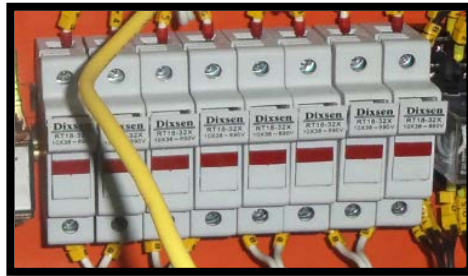
Figura 2.5: Base Porta fusible tipo 10x38 mm de 32Amp -240V
