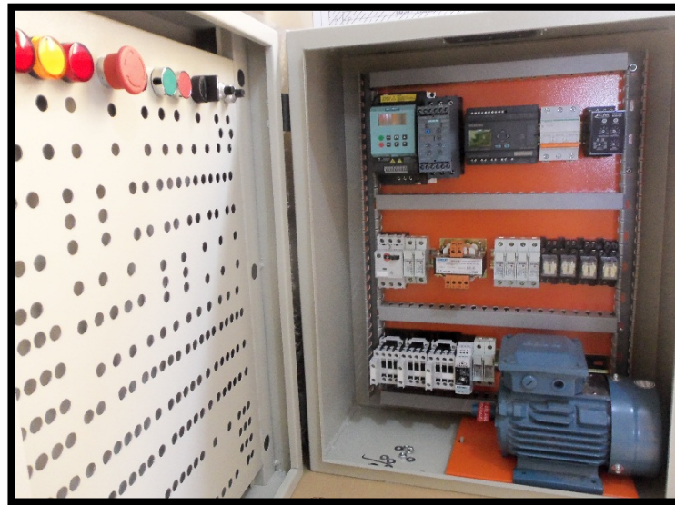
Figura 3.7: Módulo Didáctico, montaje de equipos eléctricos y electrónicos
