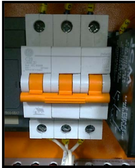
Figura 2.8: Disyuntor de 3P-20Amp – 240V
