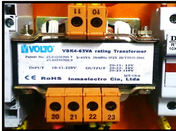
Figura 2.10: Transformador de 63VA-12/110V
