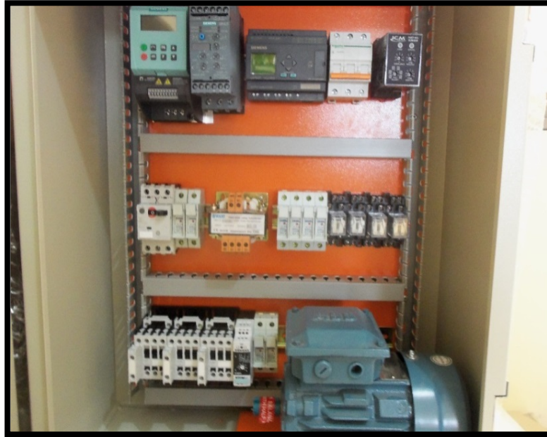
Figura 3.12: Montaje de elementos eléctricos y electrónicos
