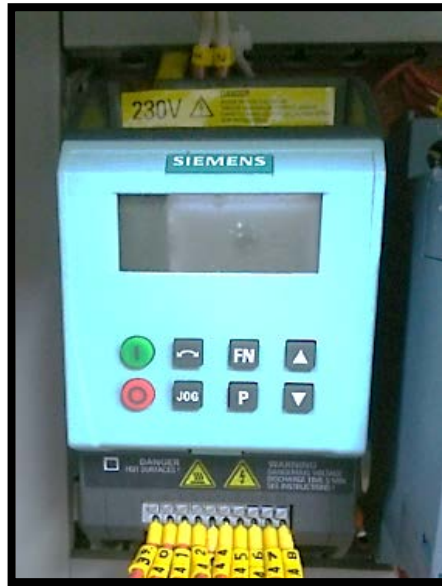
Figura 2.2: Variador de Frecuencia Sinamic G110
