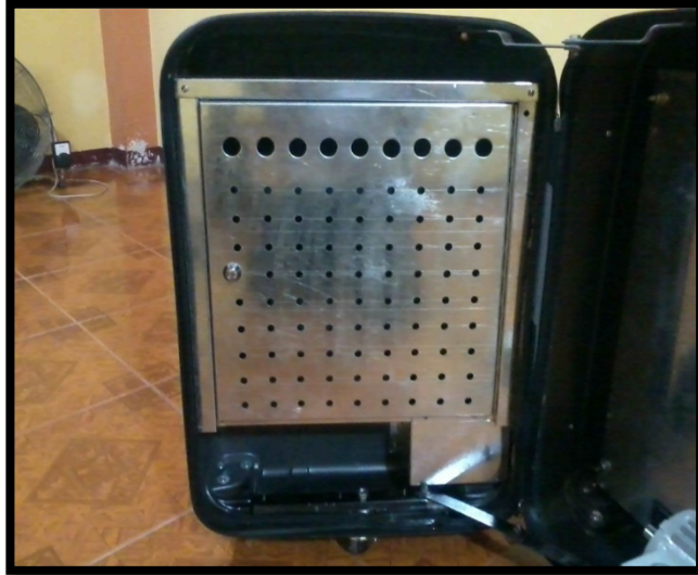
Figura 3.1: Módulo Didáctico, lámina de acceso al cableado de control y fuerza
