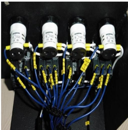
**Figura 3.16** Etiquetado de los conductores.
