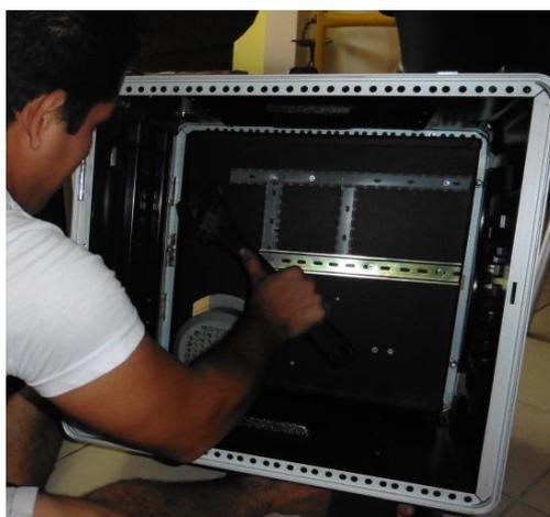
**Figura 3.12** Instalación de prensas estopas.
