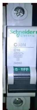
Figura 73: Breaker C60N Fuente: Laboratorio de Motores y Generadores
