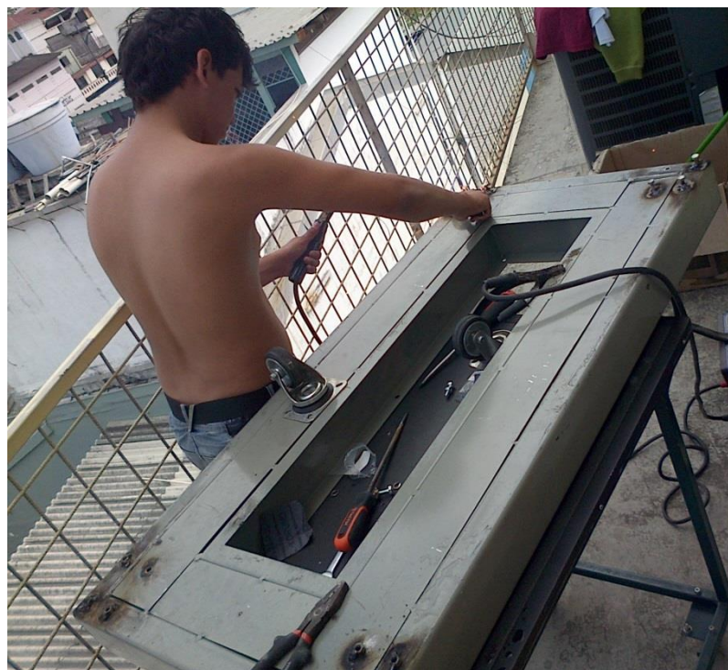
Figura 37: M.A.P.P.E. Proceso de soldadura de la base antivuelco. Fuente: Los Autores
