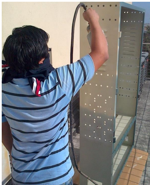
Figura 34:M.A.P.P.E. Proceso de Pintado del lado lateral del módulo. Fuente: Los Autores
