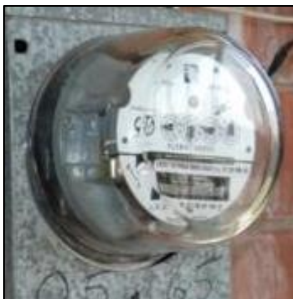
Figura 16: Medidor de energía eléctrica de disco. En la figura se muestra un medidor con similares características a los utilizados en el módulo didáctico. Recuperado el 24 de abril del 2015, de http://www.panoramadelpacifico.com/wp-content/uploads/2010/01/personas-se-hacen-pasar-como-de-cfe-en-el-df.jpg
