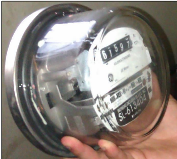
Figura 27: Vista lateral del Contador de Energía. Imagen del modelo utilizado.
