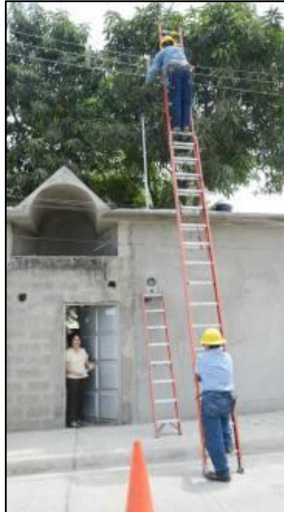
Figura 20: Acometida eléctrica a 240VAC. Empleados de la empresa eléctrica instalan una acometida eléctrica residencial. Recuperado el 24 de abril del 2015, de http://www.eluniverso.com/noticias/2014/08/26/nota/3550626/280-medidores-220-v-se-instalan-semana
