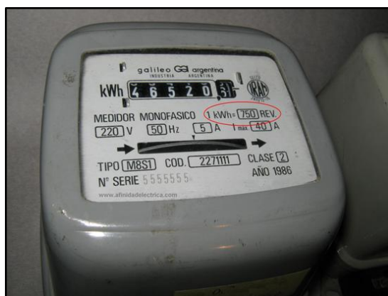
Figura 17: Medidor monofásico. Características principales del dato de placas frontal de un contador de energía. Dato extraído el 5 de abril del 2015 desde http://www.afinidadelectrica.com.ar/html/Image/articulo138-prueba potencia /art138 - contraste-constantem.JPG
