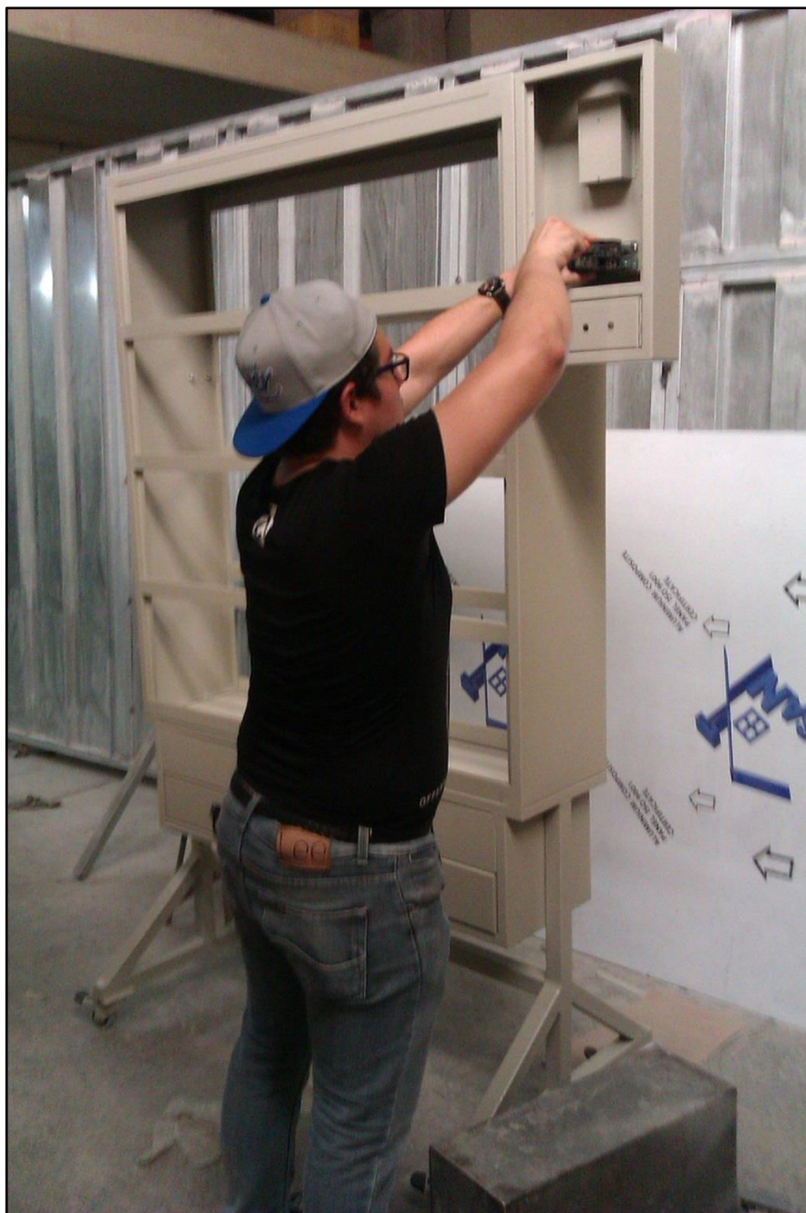
Figura 1: Tablero didáctico en proceso de construcción, ajustes de los disyuntores principales.
