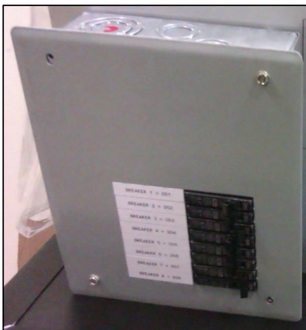
Figura 28: Vista del Panel de Distribución. Imagen del modelo utilizado.
