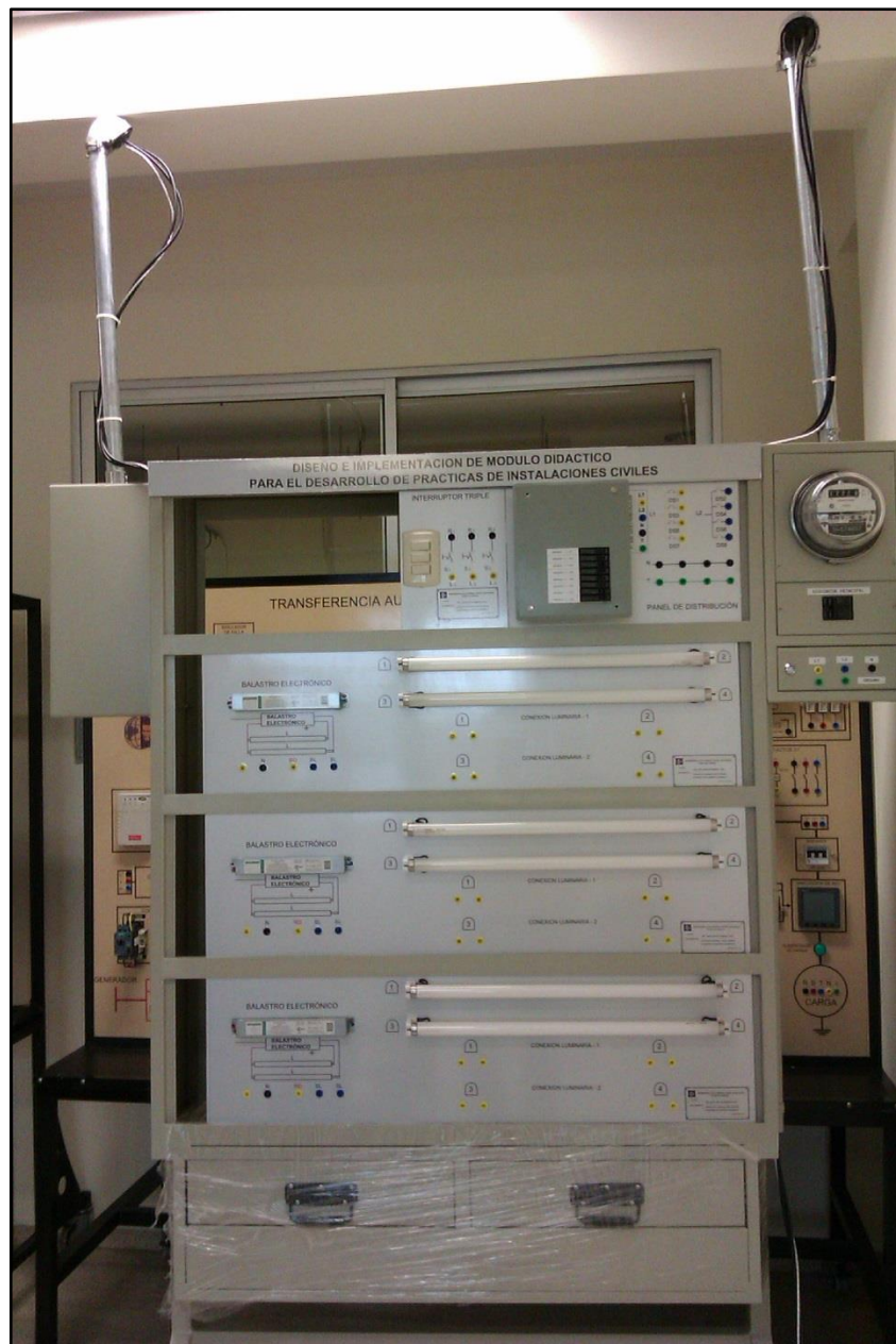
Figura 37: Imagen donde se muestra la forma de colocar las láminas didácticas, en la práctica, evitando el uso innecesario de cables de conexión.
