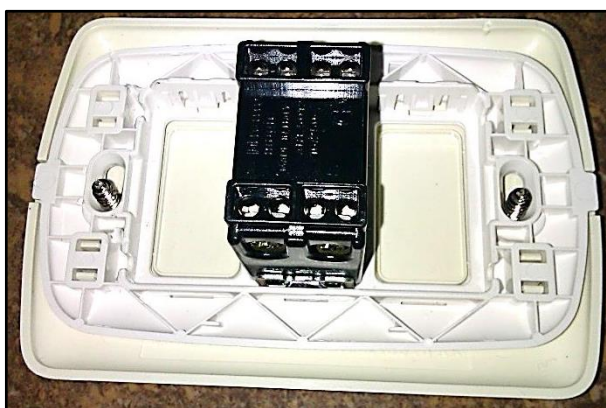
Figura 35: Vista posterior del interruptor conmutador de 4 vías, donde se muestra claramente la unión del interruptor propiamente dicho (el taco) con la placa de un módulo.
