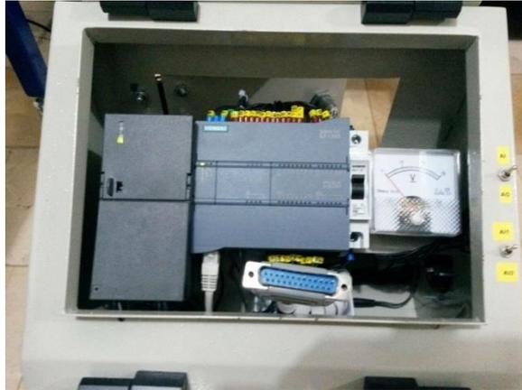
**Figura 45.-** Elementos cableados dentro de la estructura de PLC. Cableado del PLC con el conector macho DB25 que a su vez se conectará con un conector hembra DB25.
