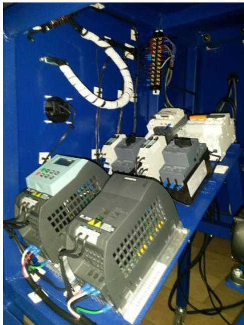
**Figura 31.-**Elementos de fuerza para los motores trifásicos. Instalación y cableado de los elementos de fuerza de la mini planta industrial.
