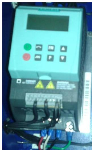
**Figura 3.-** Variador de frecuencia. Variador de frecuencia para el control de velocidad de motores.
