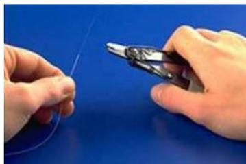
**Figura 2: Eliminación del recubrimiento de la fibra**
