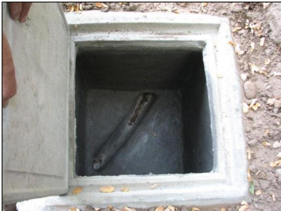
**Figura 5.3. Cámara de Inspección de canalizaciones externas.**
