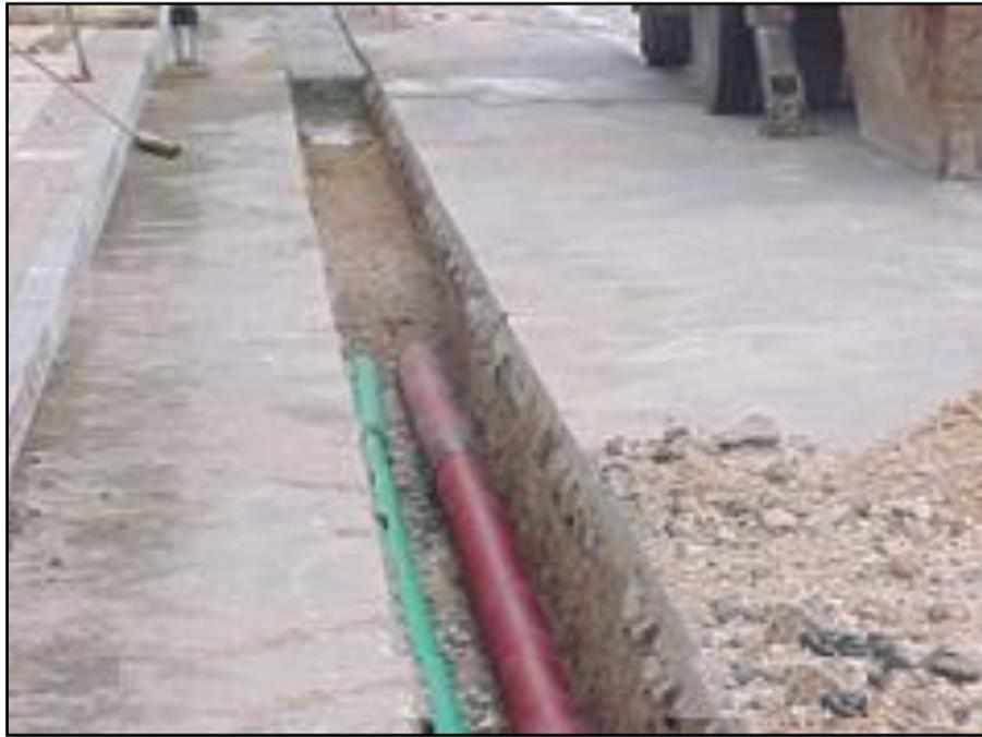
**Figura 5.2. Canalización Externa entre edificios.**
