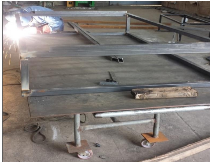
Figura 63: Construcción base metálica para elementos.
