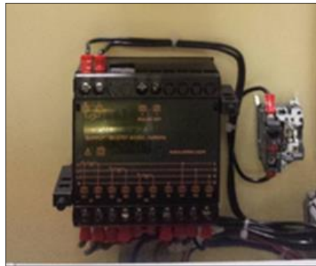
Figura 88: Cableado analizador de red.
