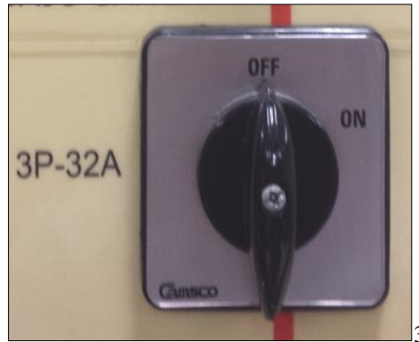
Figura 34: Interruptor de Fuerza.
