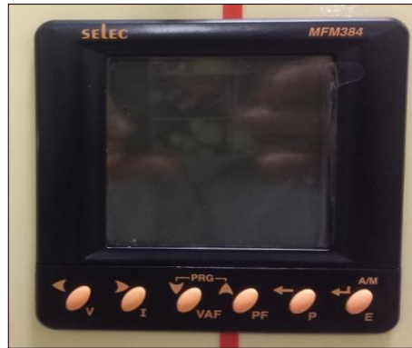
Figura 41: Medidor de Energía.
