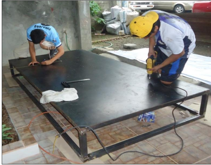
Figura 67: Perforaciones y calados en plancha metálica.
