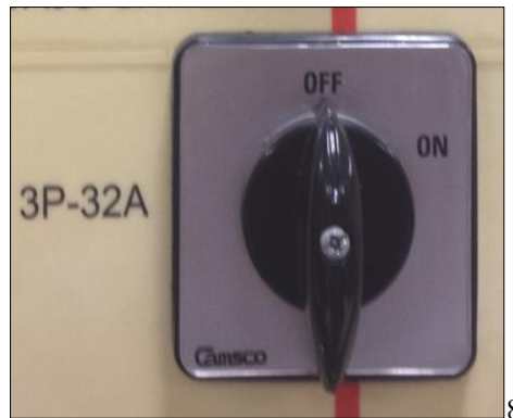
Figura 89: Interruptor de Fuerza.
