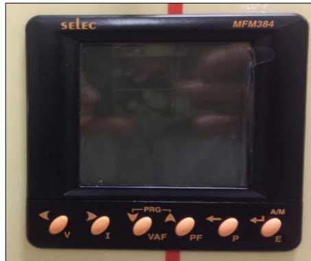
Figura 87: Analizador de red.
