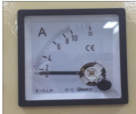
Figura 92: Amperímetro analógico AC
