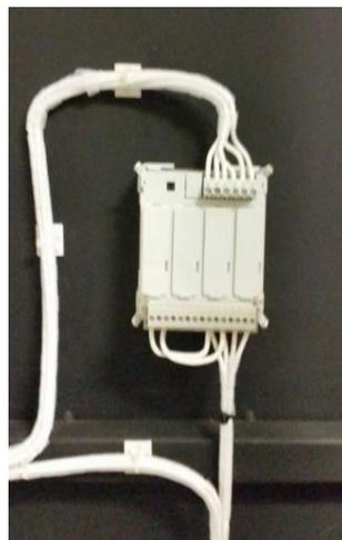
Fotografía 7. Cableado del analizador de redes
