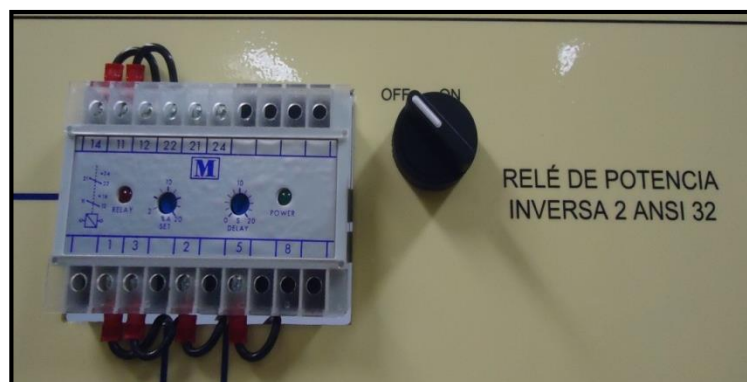
Figura 62. Relé de potencia inversa M200.
