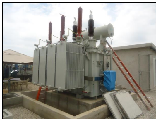
Figura 6. Transformador de potencia.
