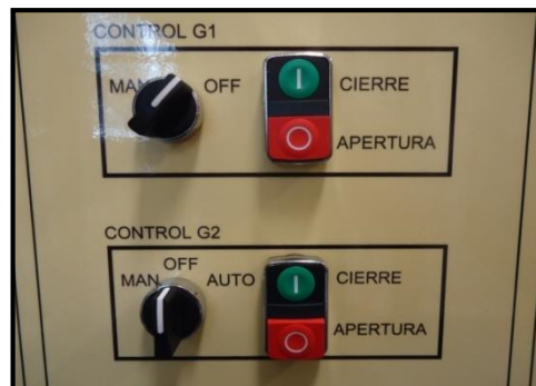
Figura 35. Control de generadores.
