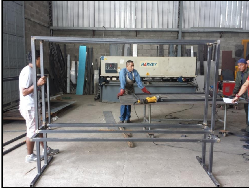
Figura 42. Construcción de la mesa de trabajo
