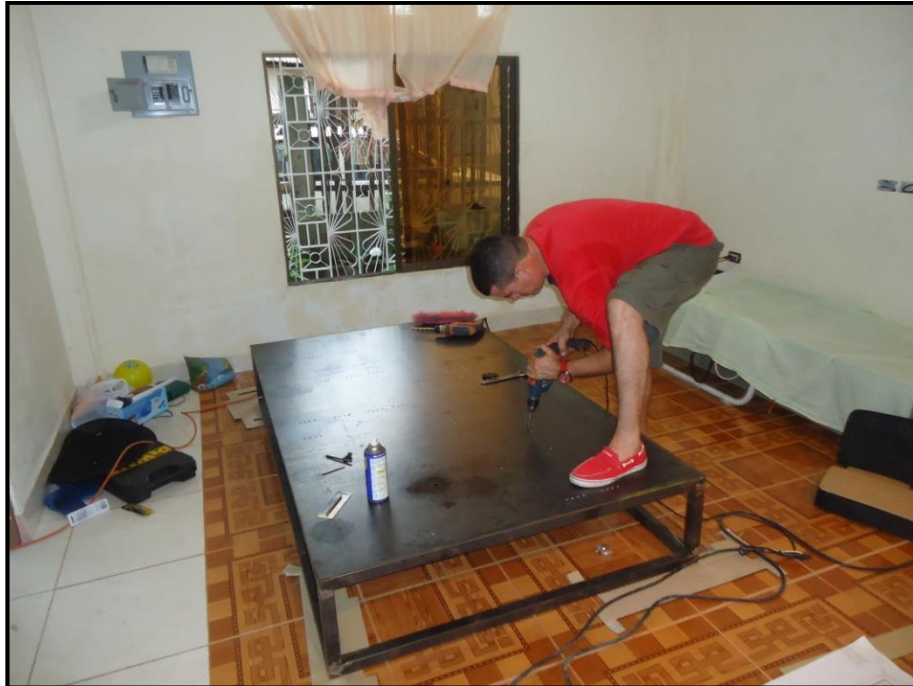
Figura 46. Perforaciones en tablero
