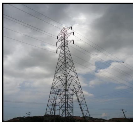
Figura 8. Línea de transmisión.
