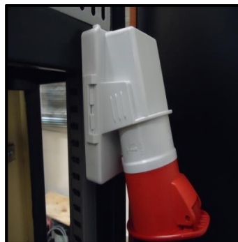
Figura 59. Alimentación circuito de control.
