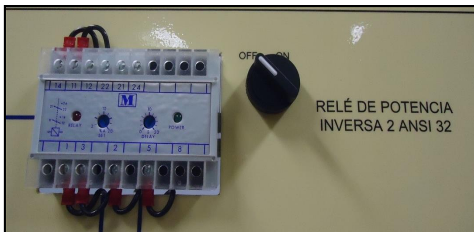
Figura 32. Relé de potencia inversa M200.
