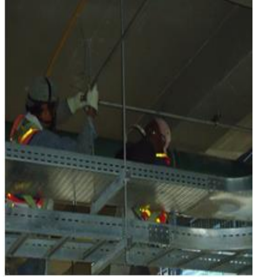
Figura 21 Montaje de la línea de oxígeno planta baja lado C y D.
