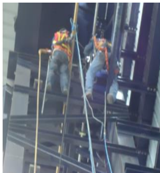
Figura 24 Montaje de la línea de oxígeno en columnas 4 a la 10 lado D.
