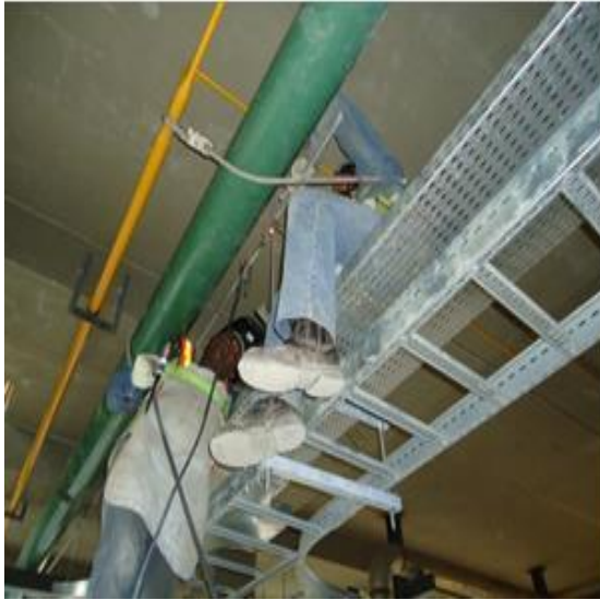
Figura 21 Montaje de la línea de oxígeno planta baja lado C y D.
