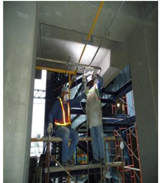
Figura 22 Montaje de la línea de oxígeno primer nivel lado C y D.
