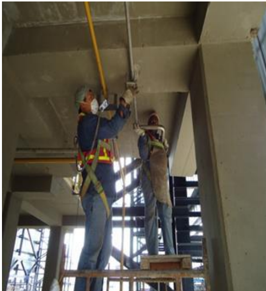
Figura 22 Montaje de la línea de oxígeno primer nivel lado C y D.
