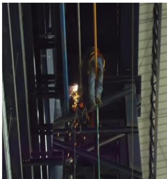
Figura 24 Montaje de la línea de oxígeno en columnas 4 a la 10 lado D.
