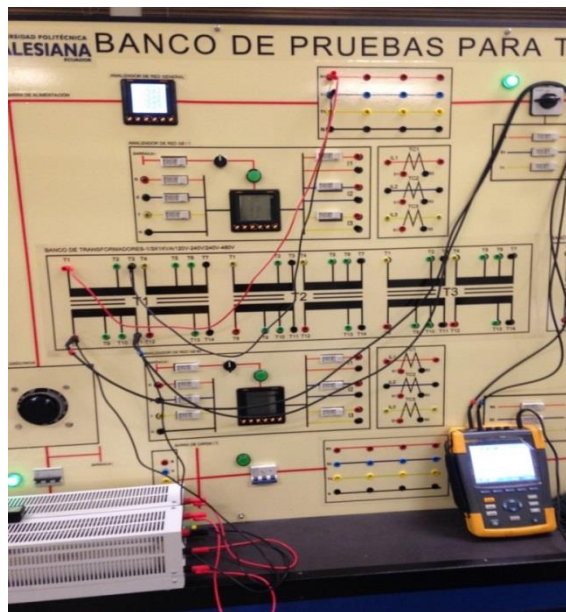
Figura 31. Tablero de ensayo en el laboratorio conectado una carga resistiva y el instrumento de medición para medir voltaje en la baja tensión
