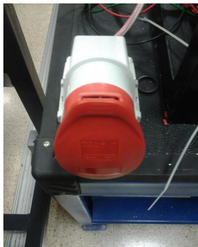
FIGURA 4. 2 Toma trifásico
