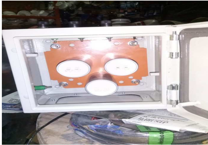
Figura 69 Montaje y adaptación de los capacitores del banco de carga LC
