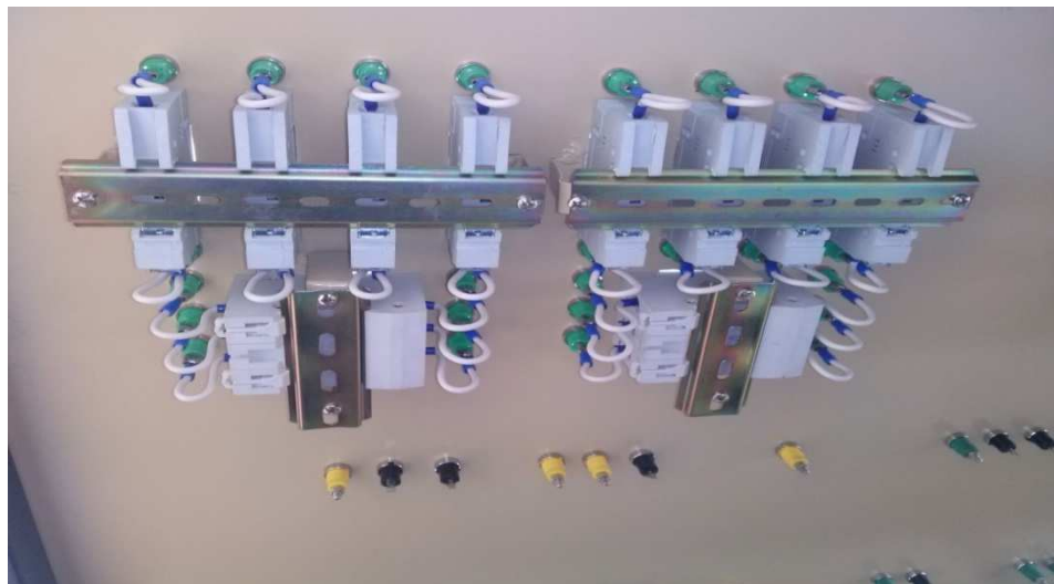
Figura 53 Montaje de elementos de protección
