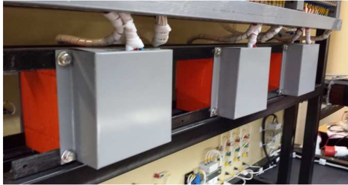
Figura 32 Transformadores monofásicos tipo seco del banco de pruebas
