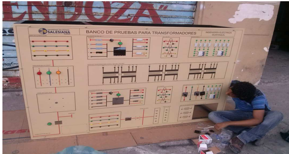
Figura 52 Colocación de borneras, luces pilotos, selectores, porta fusibles y breakers.
