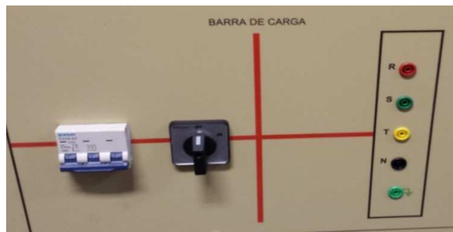
Figura 40 Selector trifásico para la carga
