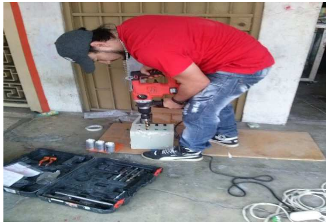
Figura 68 Perforación y montaje de las borneras de conexión tipo Jack`s bananas
