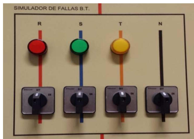
Figura 80 Elementos eléctricos de señalización
