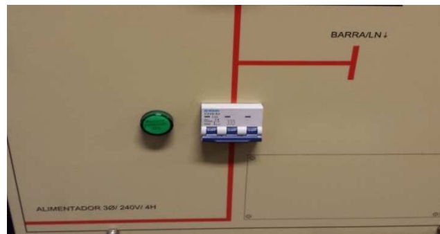
Figura 41 Disyuntor 3 polos a 20 amperios de la barra de alimentadores
