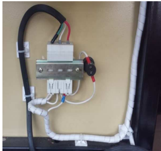
Figura 75 Alimentación trifásica del breaker principal del banco
