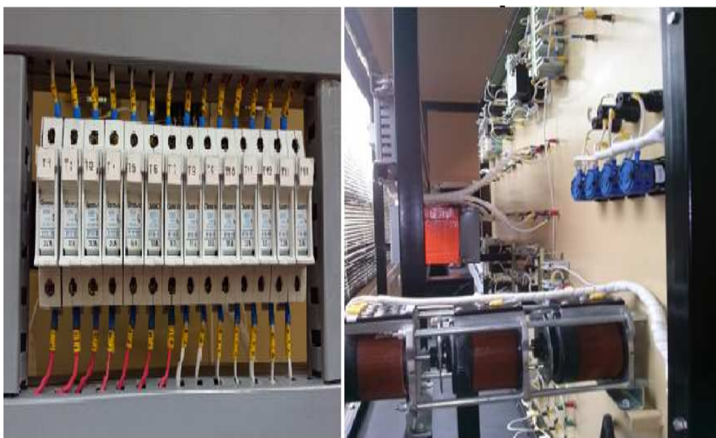
Figura 59 Conexión, cableado, marquillado y acabado interno del banco
