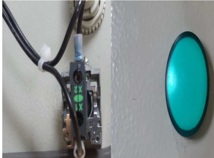
Figura 67 Luz piloto de 120-240VAC, 25mA del banco de carga LC
