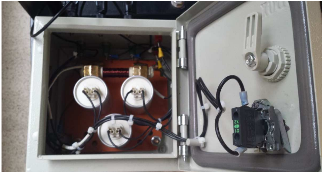
Figura 71 Conexión y cableado de los elementos del banco de carga LC
