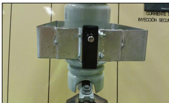
Figura 65 Fin de carrera, hay uno por cada caja portafusible.
