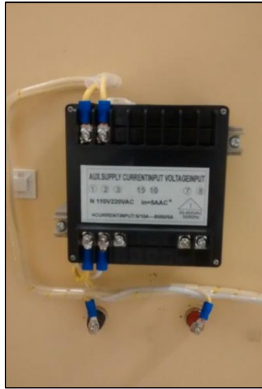
Figura 46 Vista posterior del medidor de parámetros 1.
