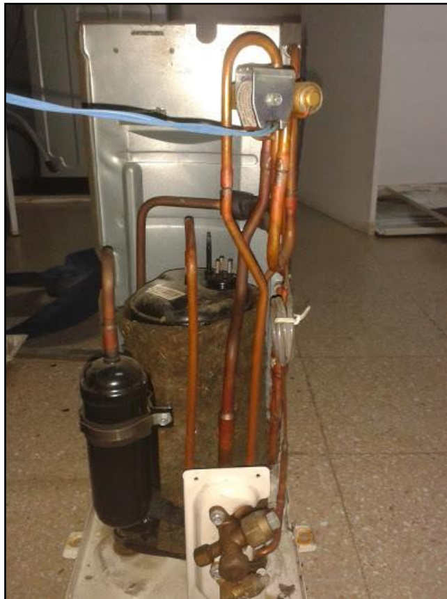
Figura 63 Condensador una vez realizado el desmontaje de la parte eléctrica
