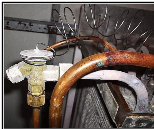
Figura 22 Válvula de expansión
