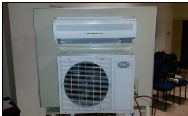
Figura 68 Montaje de evaporador y condensador
