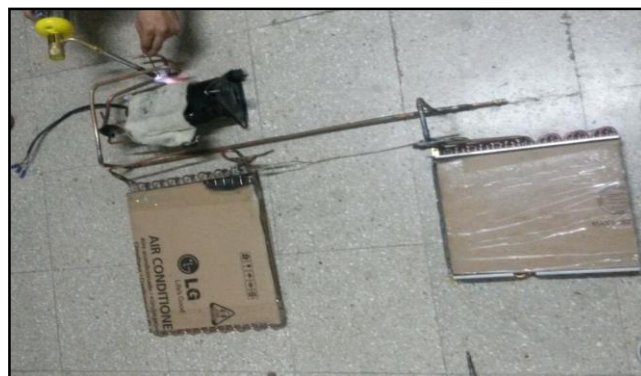
Figura 54 Soldado de tuberías de cobre
