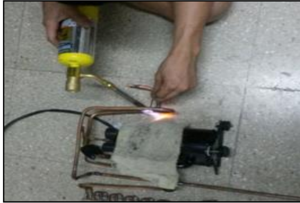
Figura 55 Soldado de tubería para colocación de manómetro
