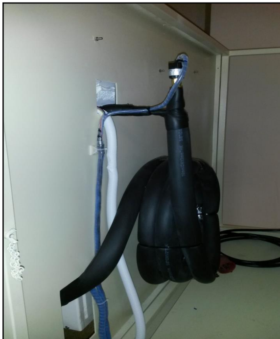
Figura 69 Instalación de tubería de cobre y revestimiento
