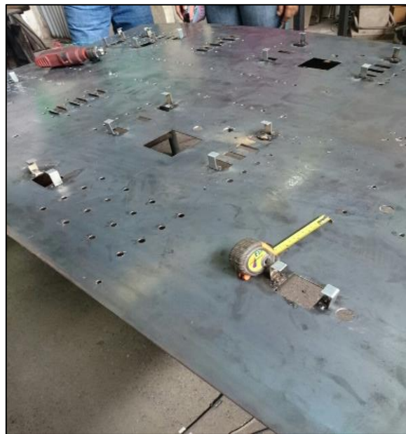
Figura 3.4: Construcción de plancha metálica
