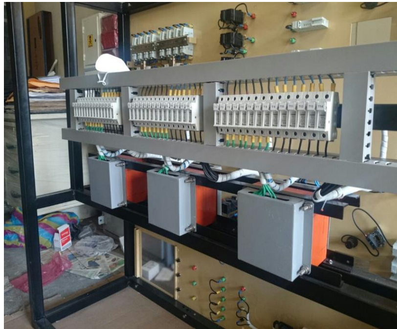
Figura 3.10: Instalación eléctrica de los equipos
