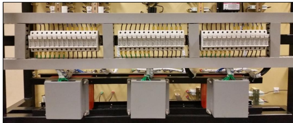
Figura 3.20: Banco de transformadores
