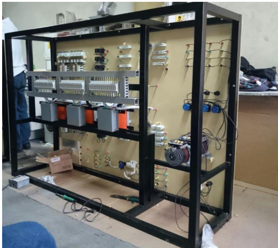
Figura 3.9: Instalación eléctrica de los equipos
