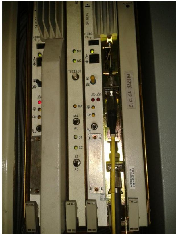
Figura: Tarjetas de cross conexión PDH.
