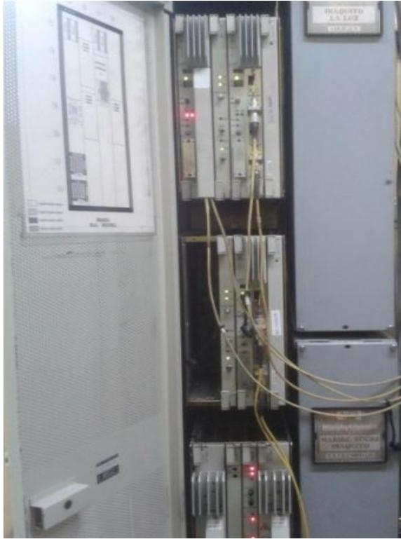
*Figura 18* Rack de equipos PDH Mall El Jardín - Iñaquito de la CNT. Fuente: CNT EP.
