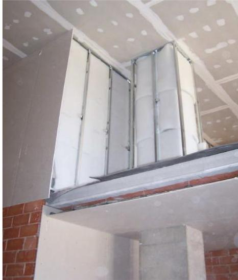
*Figura 27.* Aislamiento Acústico del techo. Fuente: (Parra, 2008)
