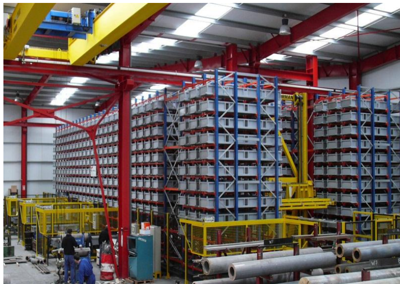
Figura 7. Vista general de un Transelevador en funcionamiento. Fuente: Atox grupo.
