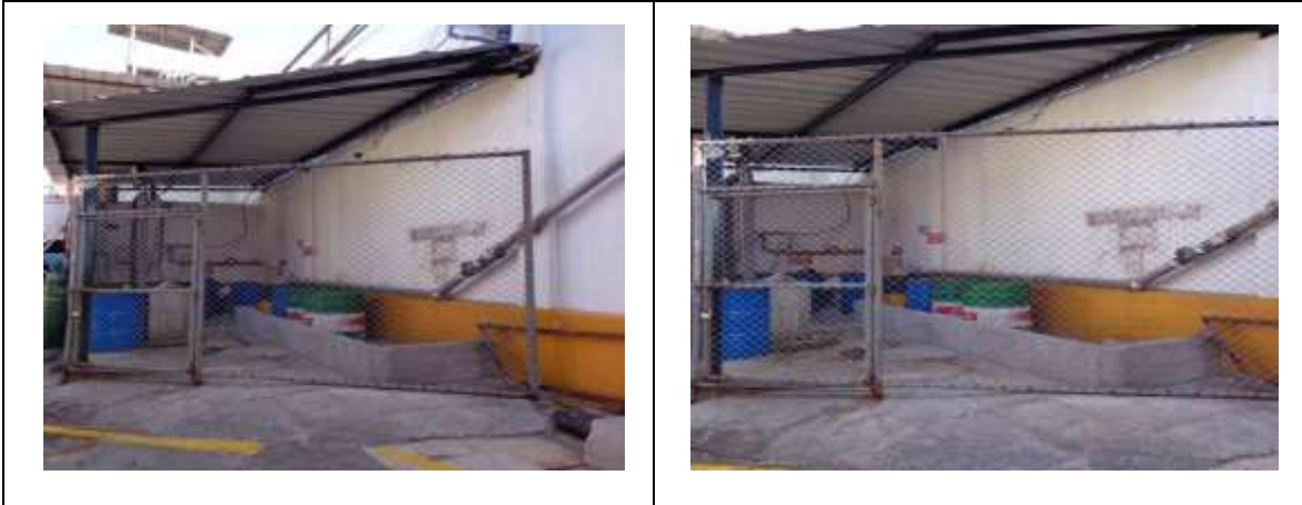
Fotografía 1: Bodega de residuos peligrosos
