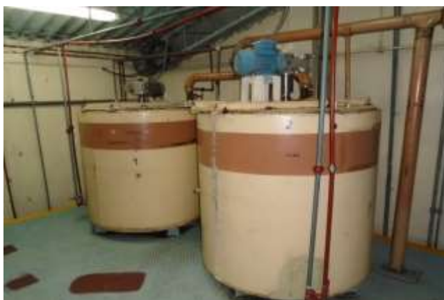
Ilustración 4.12. Tanques de almacenamiento
