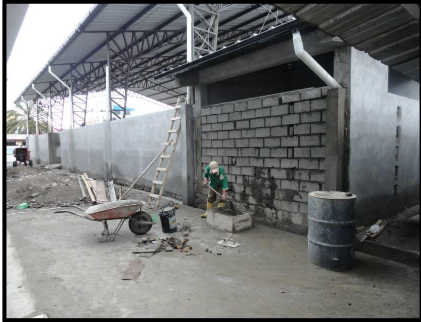
Anexo 3. Enlucido de muros
