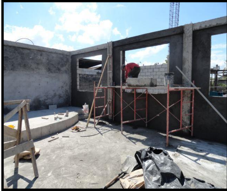
Anexo 10. Construcción obra gris
