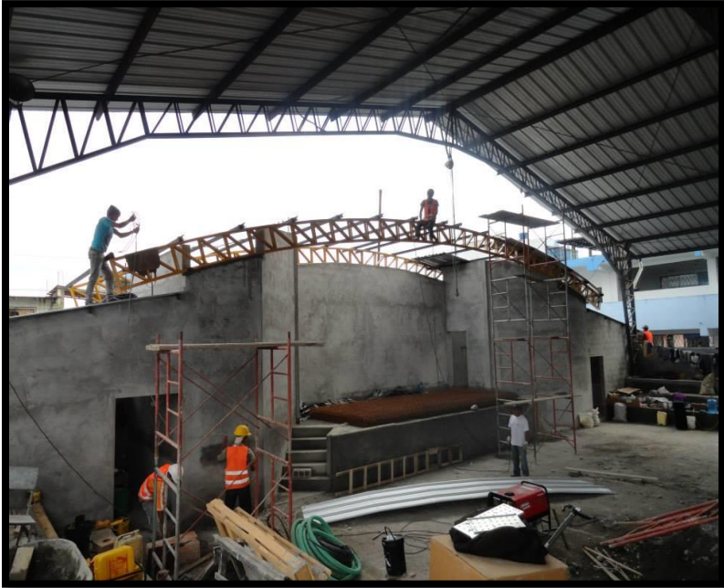
Anexo 2. Armado de estructura metálica para el techo
