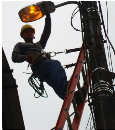
Figura 16 Nuestro personal es altamente capacitado para realizar todo tipo de trabajo eléctrico
