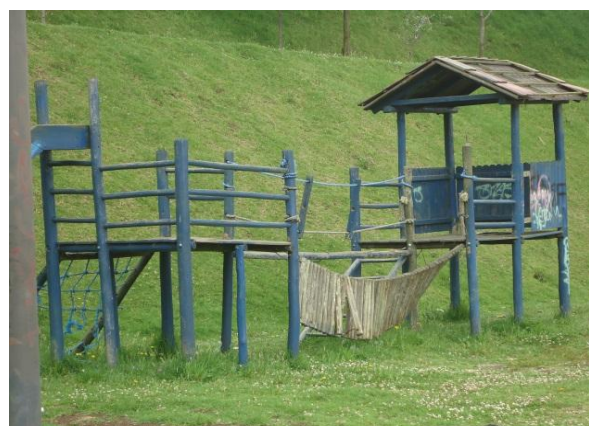
Foto observación infraestructura 2014.
