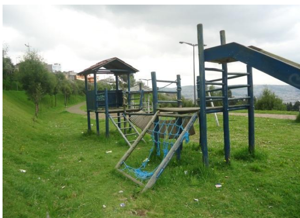
Foto observación –infraestructura 2014.
