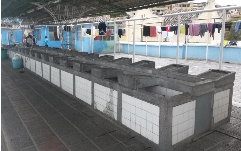
Piedras de lavar de las lavanderías De Los Milagros en el barrio La Loma
