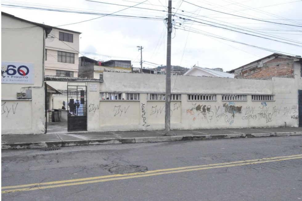
Fachada de las lavanderías Chiriyacu en el barrio de Chimbacalle
