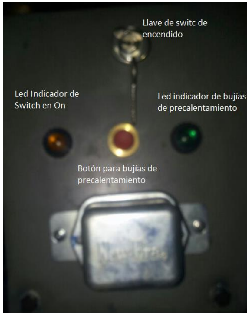
Figura 4. 1 Tablero de mando para encendido del motor
