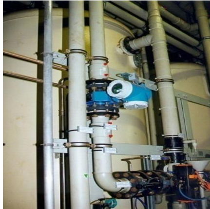
Figura 3.5 Equipos de Medición de flujo.
