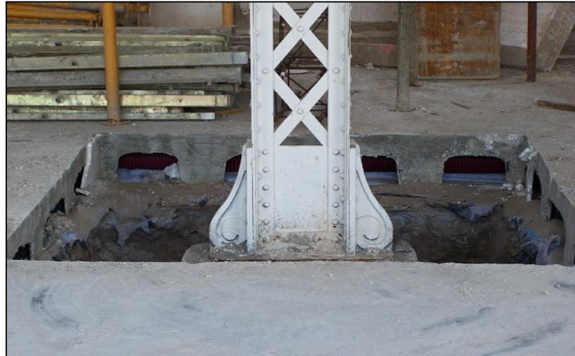
Gráfico 5. Columna construida en celosía
