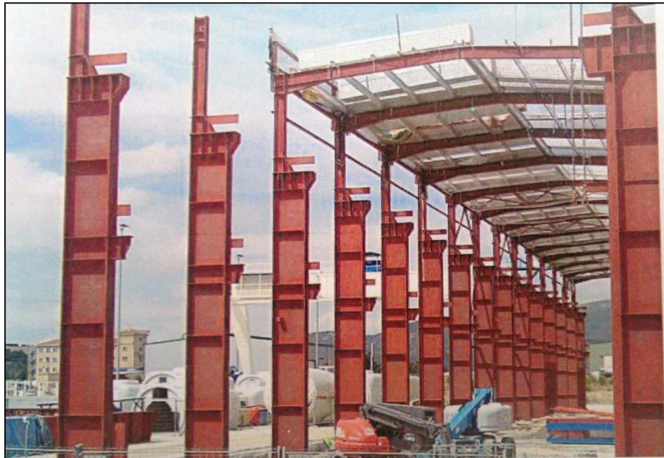
Gráfico 7. Columnas y vigas de alma llena armadas
