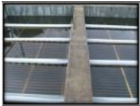
Figura 1.9 Sedimentador de placas paralelas
