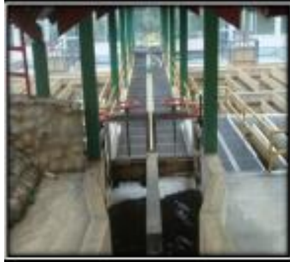
Figura 1.7 Compuerta que regula el ingreso de agua al floculador
