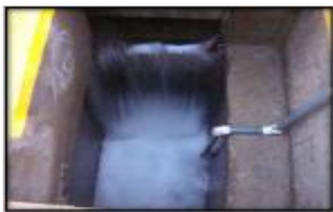
Figura 1.12 Punto de inyección de cloro en la cámara de contacto
