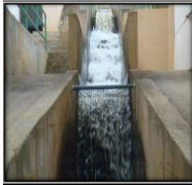
Figura 1.5 Resalto hidráulico dosificadora
