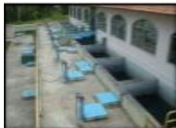
Figura 1.11 Batería de filtros
