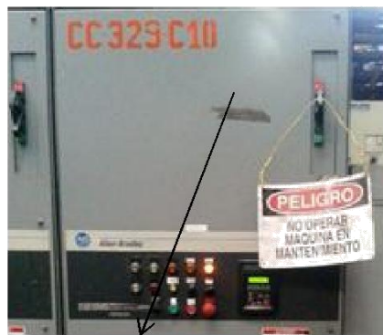
Breaker de motor de bomba
