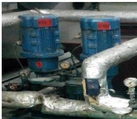
Figura 29: Bomba de tornillos
