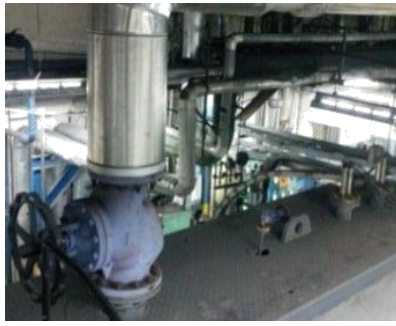
Figura 15: Esquema de una válvula de interrupción para caldero
