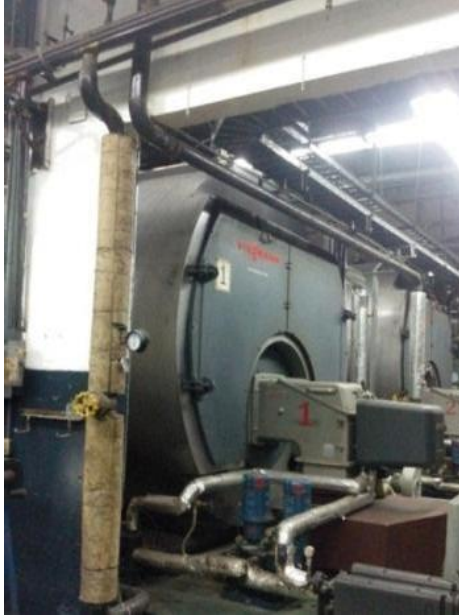
Figura 27: Tubería de ingreso de bunker al caldero y tubería de
