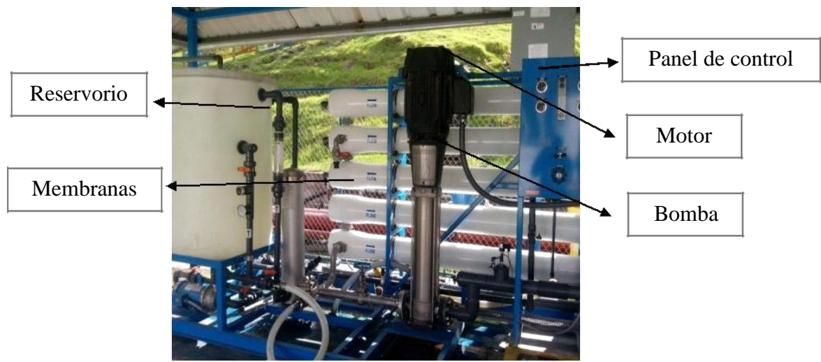
Figura 16: Máquina de tratamiento de osmosis inversa
