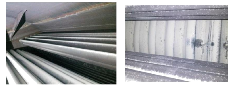
Figura 4: Banco de tubos del caldero 2 (mantenimiento del 2014)
