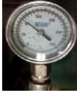
Figura 31: Temperatura de ingreso de bunker (100°C)
