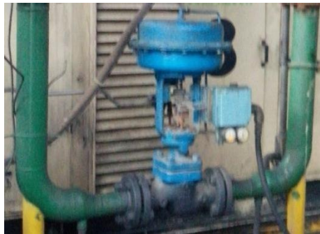
Figura 22: Válvula de control de ingreso de agua
