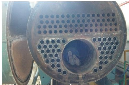
Figura 8: Baqueteado de haz de tubos
