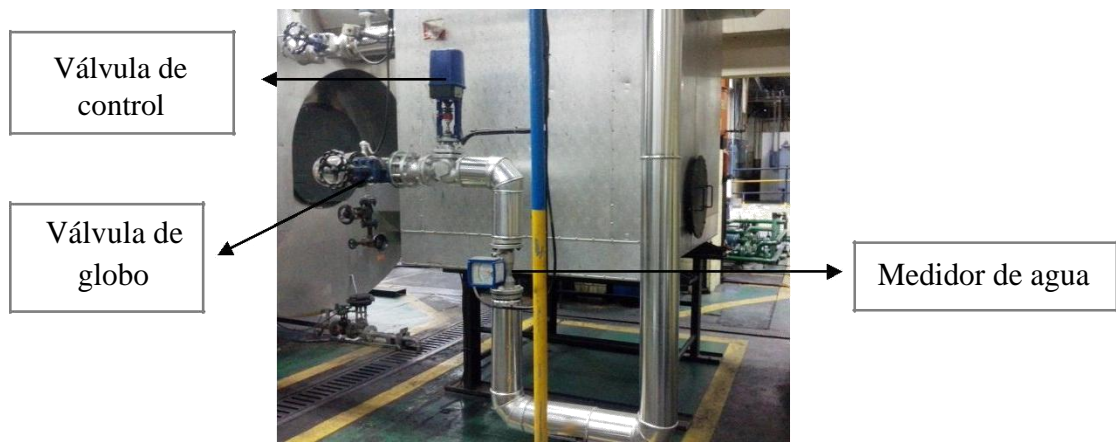
Figura 24: Sistema de control del economizador
