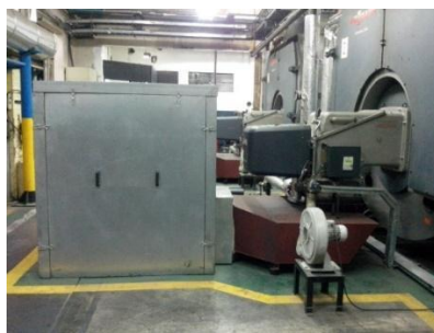
Figura 32: Quemador instalado en planta
