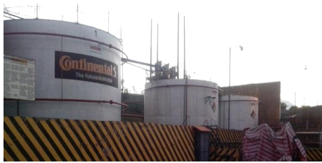
Figura 25: Tres tanque de almacenamiento de bunker
