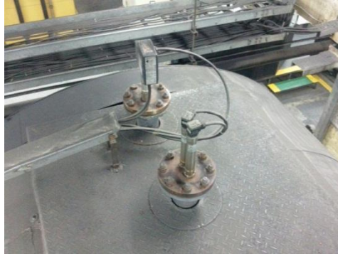
Figura 9: Sensor de nivel de agua
