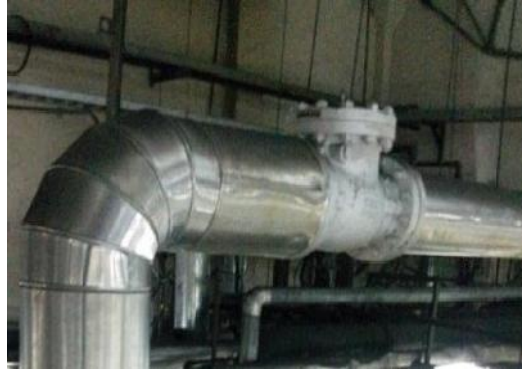
Figura 14: Válvula check instalada a la salida de vapor del caldero
