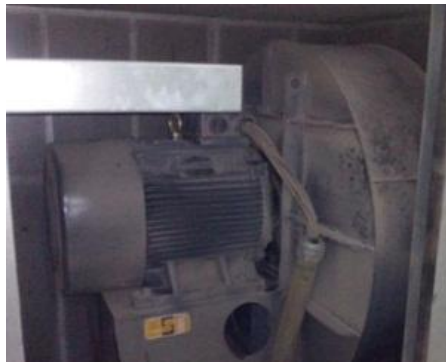
Figura 35: Motor del ventilador de aire de tiro forzado para el caldero
