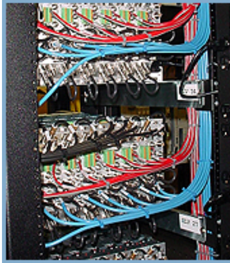
FIGURA 4.15. CORRECTA DISTRIBUCIÓN DEL CABLEADO EN LOS EQUIPOS DEL RACK 27
