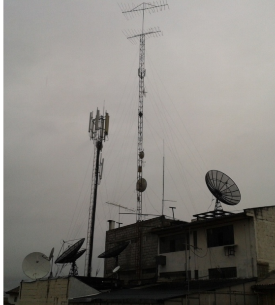
FIGURA 4.9. CONJUNTO DE ANTENAS CABLETEL-SERPORMUL 2012
