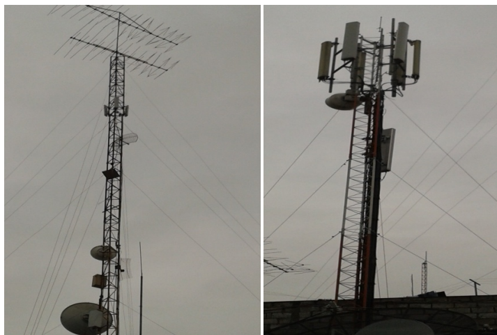
FIGURA 4.10. ANTENAS TIPO YAGUI-SECTORIAL-UHF-VHF CABLETEL-SERPORMUL 2012
