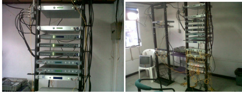
FIGURA 4.12. EQUIPOS ETAPA DE PASO DE COAXIAL A FIBRA ÓPTICA CABLETEL-SERPORMUL 2012
